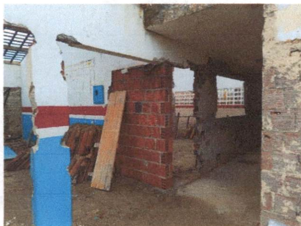
Foto 3: Demolição de alvenarias. Comprova o item 1.1.2.
