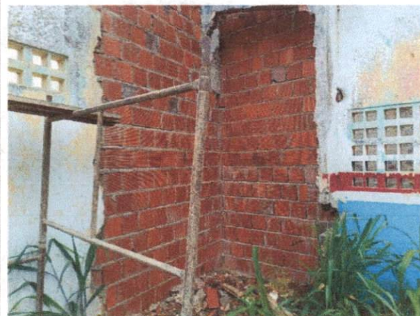
Foto 4: Demolição de alvenarias. Comprova o item 1.1.2.
