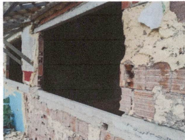
Foto 18: Demolição de argamassa. Comprova o item 3.18.
