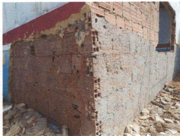
Foto 14: Demolição de argamassa. Comprova o item 3.18.
