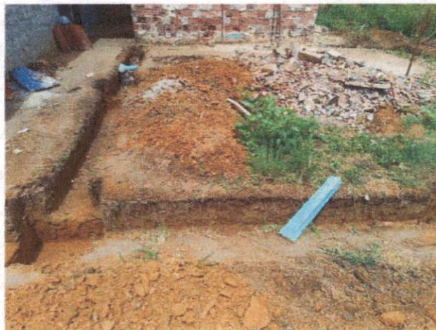
Foto 22: Escavação manual de valas, Biblioteca/Brinquedoteca. Comprova o item 3.29.
