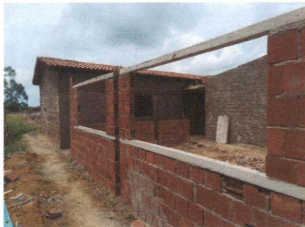
Foto 5: Vergas e contra vergas, Biblioteca/Brinquedoteca. Comprova os itens 2.2.6, 2.2.7 e 3.27.
