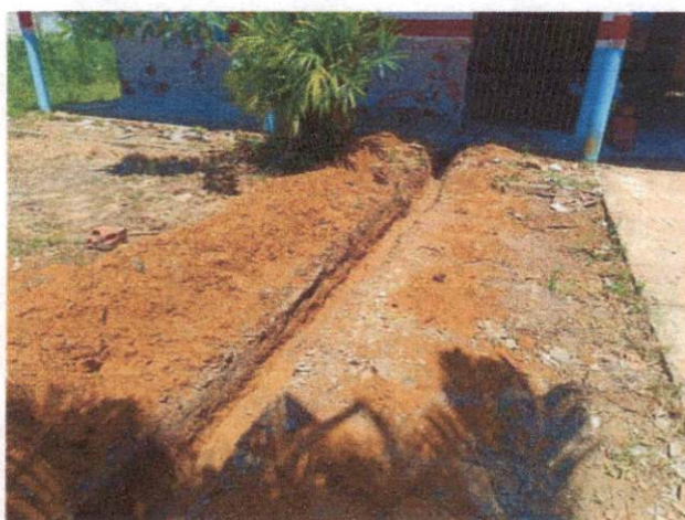
Foto 24: Escavação manual de valas, Entrada principal. Comprova o item 3.29.
