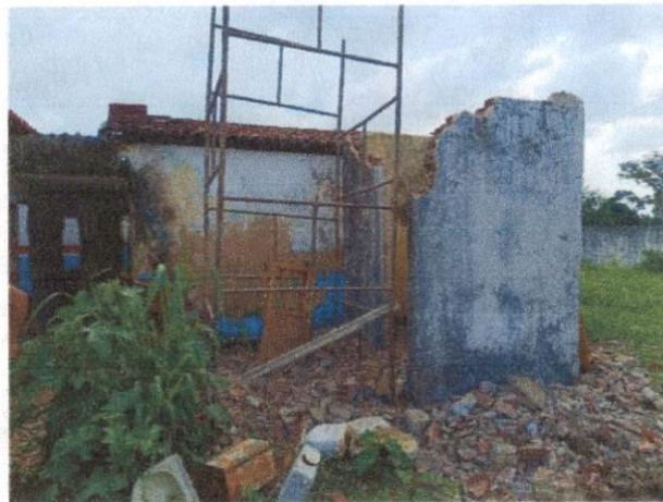
Foto 12: Demolição de laje, suporte da caixa d'água. Comprova o item 3.6.
