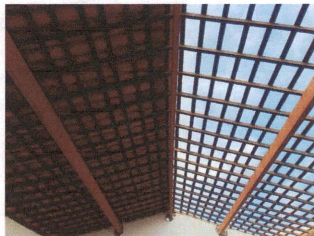
Foto 8: Linha de madeira para cobertura (terças). Comprova o item 3.1.
