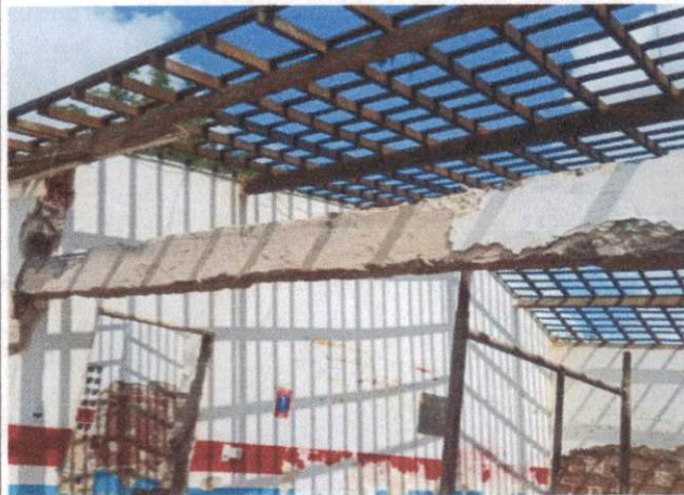
Foto 2: Demolição de alvenarias. Comprova o item 1.1.2.
