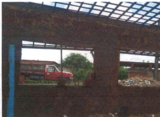
Foto 15: Demolição de argamassa. Comprova o item 3.18.
