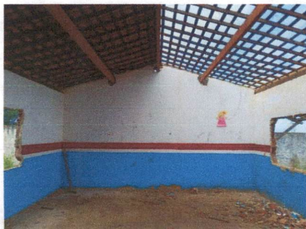
Foto 7: Linha de madeira para cobertura (terças). Comprova o item 3.1.
