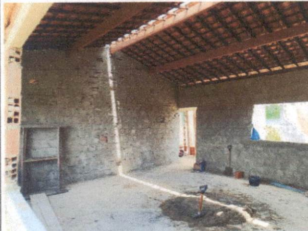
Foto 10: Linha de madeira para cobertura (terças). Comprova o item 3.1.
