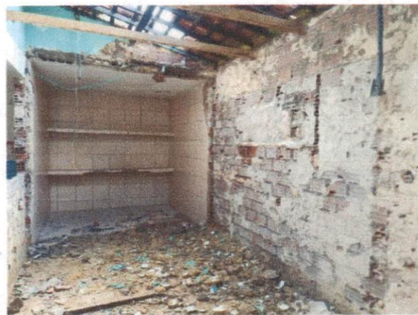
Foto 11: Demolição de laje, Despensa da Cozinha. Comprova o item 3.6.
