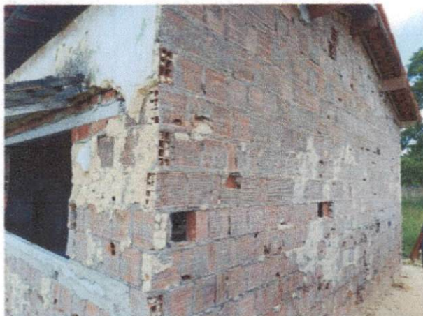
Foto 17: Demolição de argamassa. Comprova o item 3.18.
