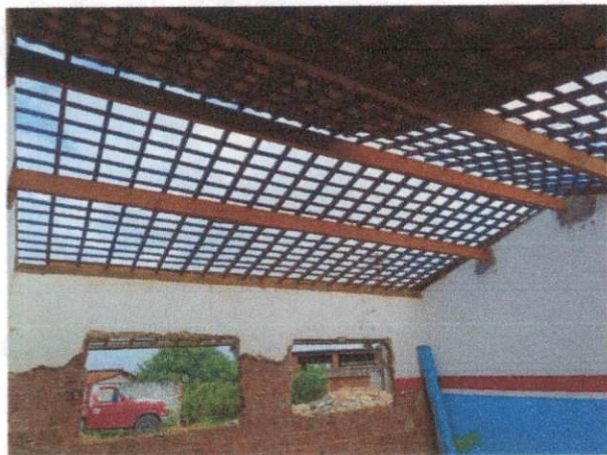
Foto 9: Linha de madeira para cobertura (terças). Comprova o item 3.1.
