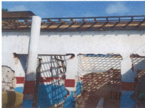
Foto 1: Demolição de alvenarias. Comprova o item 1.1.2.
