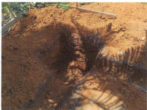
Foto 23: Escavação manual de valas, Entrada principal. Comprova o item 3.29.
