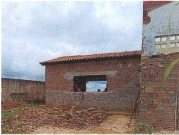
Foto 20: Demolição de argamassa. Comprova o item 3.18.
