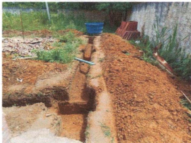
Foto 21: Escavação manual de valas, Biblioteca/Brinquedoteca. Comprova o item 3.29.
