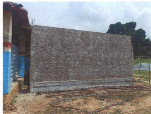
Foto 8: Alvenaria e chapisco. Comprova os itens 2.4.1 e 2.4.2
