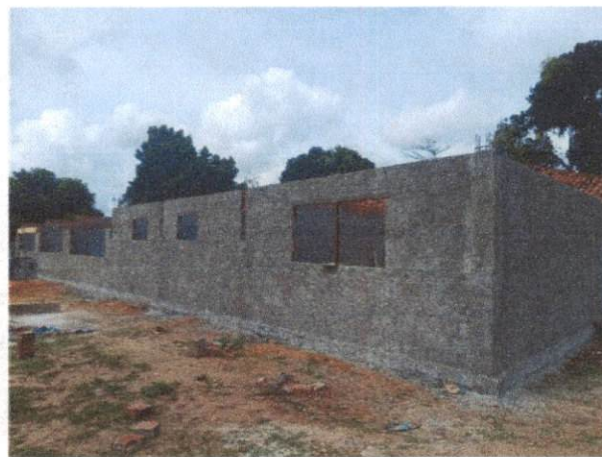
Foto 12: Alvenaria e chapisco. Comprova os itens 2.4.1 e 2.4.2
