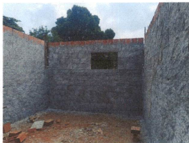
Foto 10: Alvenaria e chapisco. Comprova os itens 2.4.1 e 2.4.2.
