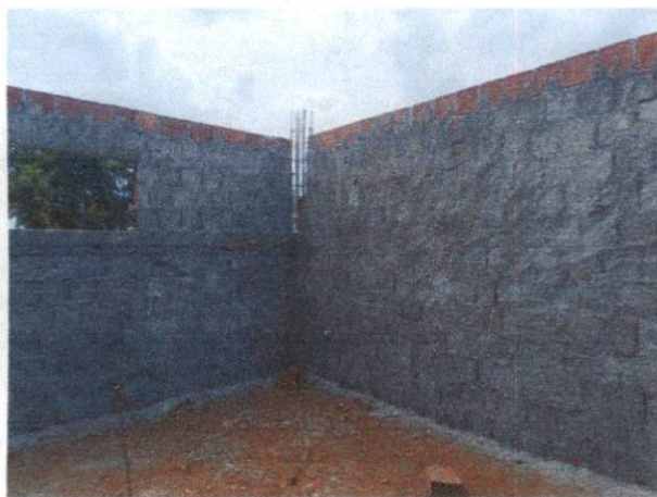
Foto 11: Alvenaria e chapisco. Comprova os itens 2.4.1 e 2.4.2
