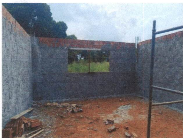
Foto 9: Alvenaria e chapisco. Comprova os itens 2.4.1 e 2.4.2
