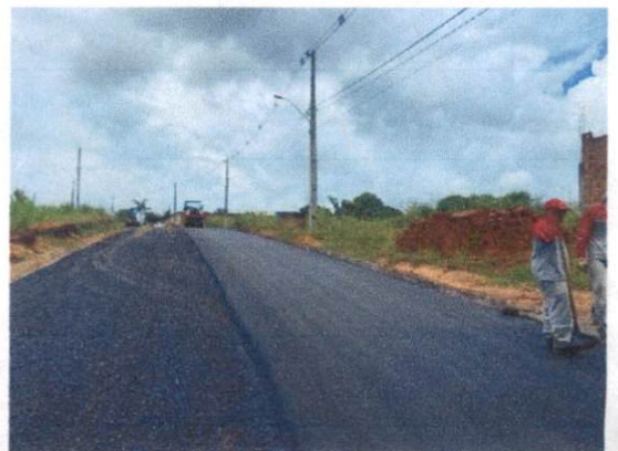
Item:1.5.3. EXECUÇÃO DE PAVIMENTO COM APLICAÇÃO DE CONCRETO ASFÁLTICO, CAMADA DE BINDER - EXCLUSIVE CARGA E TRANSPORTE.
