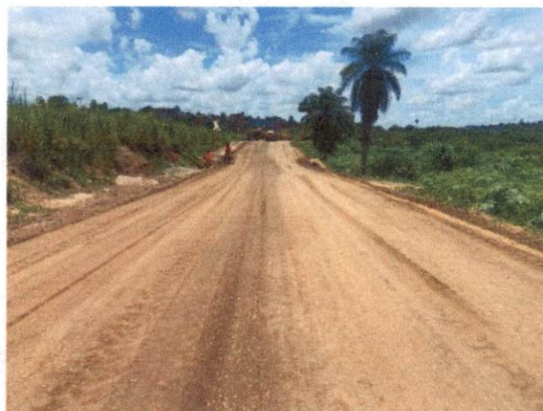
Item: 1.4.1.- BASE ESTABILIZADA GRANULOMETRICAMENTE COM MISTURA SOLO BRITA (70% - 30%) NA PISTA COM MATERIAL DE JAZIDA E BRITA COMERCIAL
