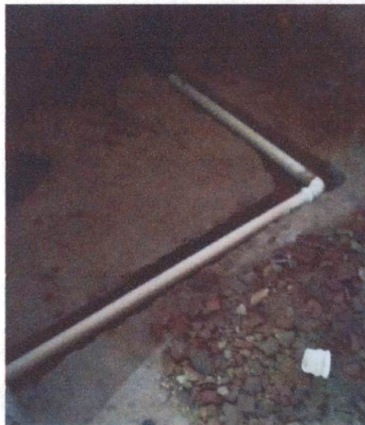
ITEM: 10.3 RASGO EM CONTRAPISO PARA RAMAIS/ DISTRIBUIÇÃO COM DIÂMETROS MAIORES QUE 75 MM. AF_05/2015 Laboratório hospital
