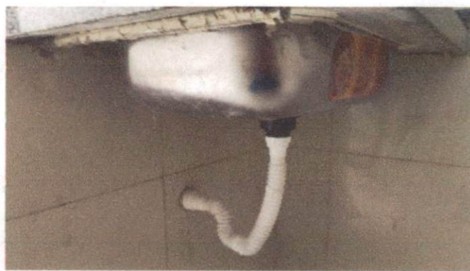
ITEM: 10.7 SIFÃO DO TIPO GARRAFA/COPO EM PVC 1.1/4 X 1.1/2 - FORNECIMENTO E INSTALAÇÃO. AF_01/2020 Laboratório hospital
