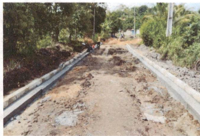
Descrição: AVENIDA DO CANAL ( PRIMAVERA ) – ITEM 1.4.2 - ASSENTAMENTO DE GUIA (MEIO – FIO); ITEM 1.4.3 - EXECUÇÃO DE SARJETA DE CONCRETO
