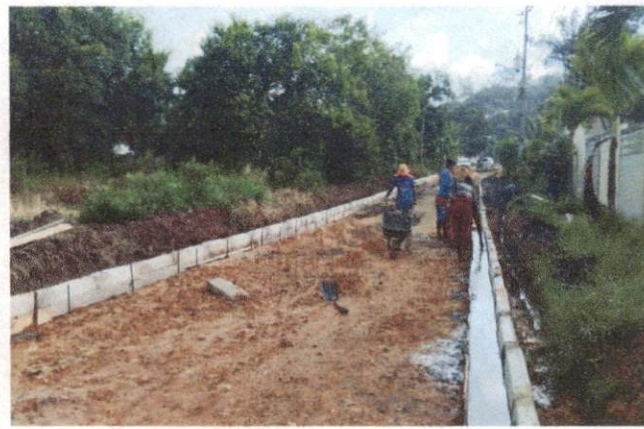
Descrição: AVENIDA DO CANAL ( PRIMAVERA ) – ITEM 1.4.2 - ASSENTAMENTO DE GUIA (MEIO – FIO); ITEM 1.4.3 - EXECUÇÃO DE SARJETA DE CONCRETO
