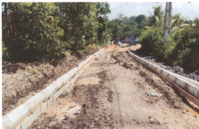
Descrição: AVENIDA DO CANAL ( PRIMAVERA ) – ITEM 1.4.2 - ASSENTAMENTO DE GUIA (MEIO – FIO);
