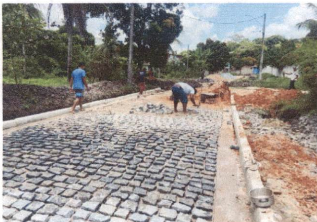
Descrição: AVENIDA DO CANAL ( PRIMAVERA ) – ITEM 1.4.1 - EXECUÇÃO DE PAVIMENTO EM PARALELEPIPEDOS.
