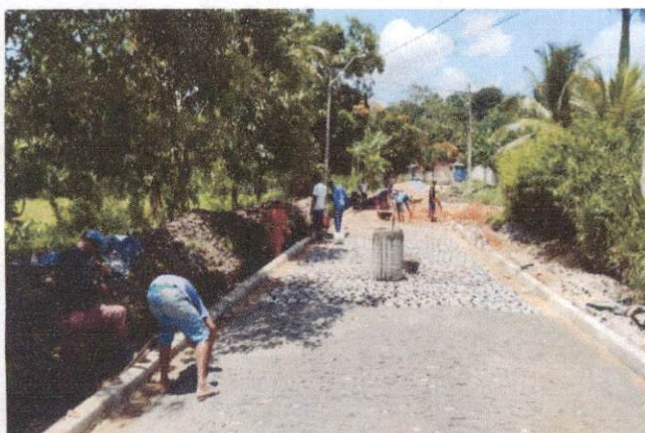
Descrição: AVENIDA DO CANAL ( PRIMAVERA ) – ITEM 1.4.1 - EXECUÇÃO DE PAVIMENTO EM PARALELEPIPEDOS.
