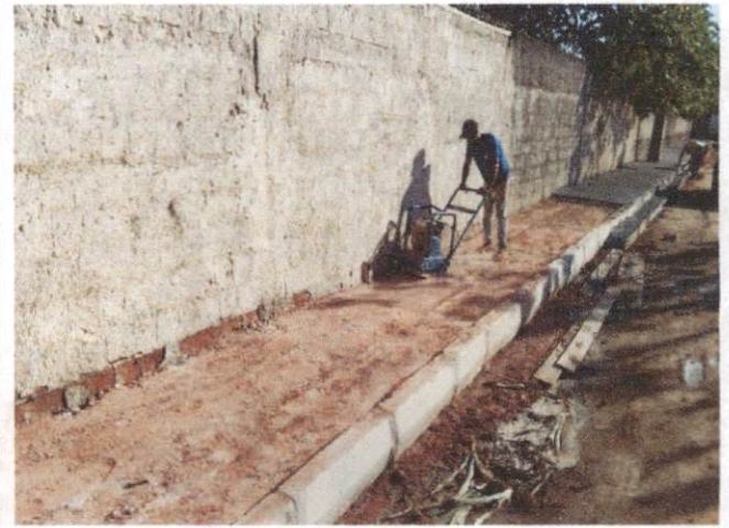
Descrição: RUA ANTÔNIO LOPES (GUADALAJARA): - ITEM 1.5.2 - ATERRO MANUAL DE VALAS COM SOLO ARGILO-ARENOSO E COMPACTAÇÃO MECANIZADA. AF_05/2016
