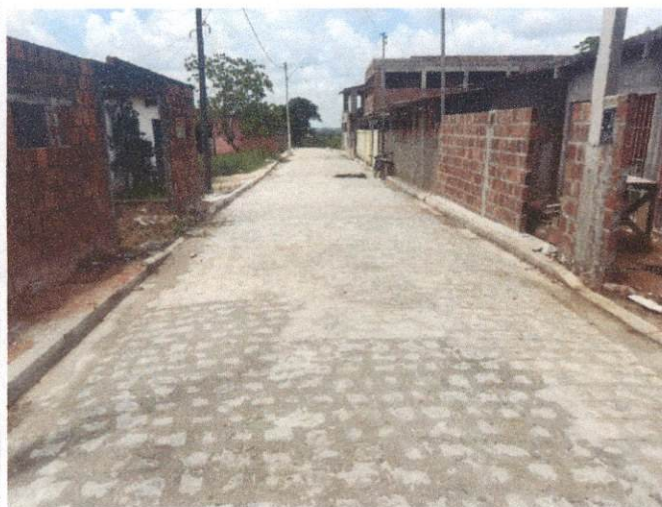
Descrição: RUA CAJUEIRO (GUADALAJARA): - ITEM 1.4.1 - EXECUÇÃO DE PAVIMENTO EM PARALELEPÍPEDOS.
