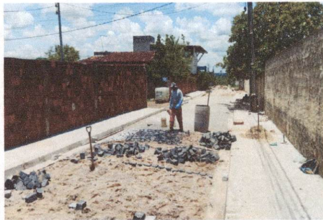
Descrição: RUA ANTÔNIO LOPES (GUADALAJARA): – 1.4.1 EXECUÇÃO DE PAVIMENTO EM PARALELEPIPEDO.
