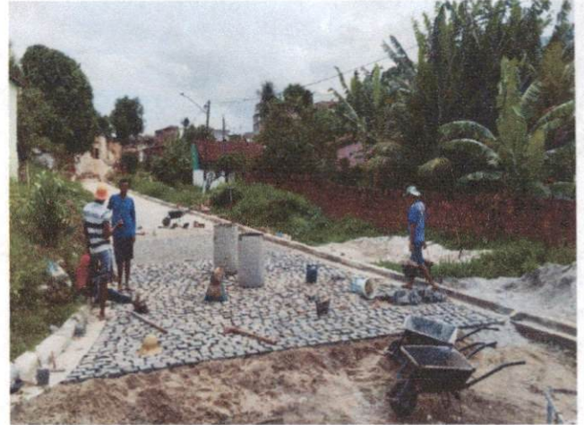
Descrição: RUA AMÉLIA FERREIRA CAVALCANTE (PRIMAVERA) ITEM 1.4.1 - EXECUÇÃO DE PAVIMENTO EM PARALELEPIPEDOS.
