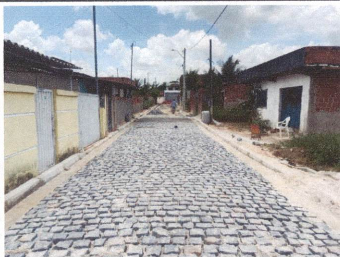
Descrição: RUA CAJUEIRO (GUADALAJARA): - ITEM 1.4.1 - EXECUÇÃO DE PAVIMENTO EM PARALELEPÍPEDOS.
