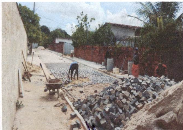
Descrição: RUA ANTÔNIO LOPES (GUADALAJARA): – 1.4.1 EXECUÇÃO DE PAVIMENTO EM PARALELEPIPEDOS
