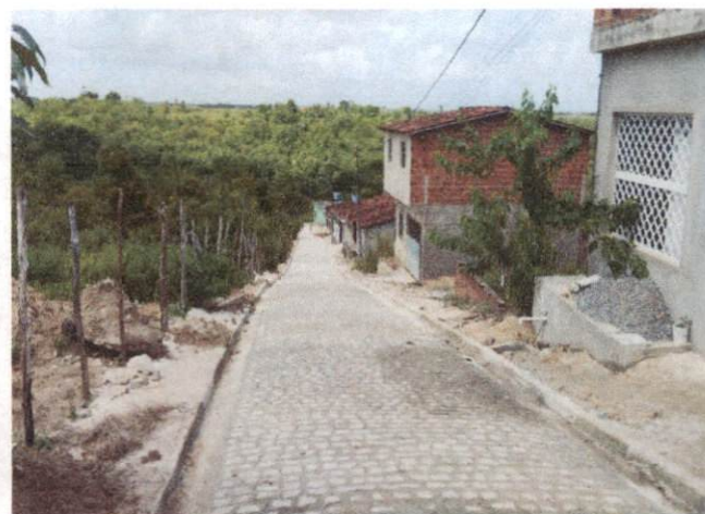
Descrição: RUA ANTÔNIO LOPES (GUADALAJARA): – 1.4.1 EXECUÇÃO DE PAVIMENTO EM PARALELEPIPEDOS.
