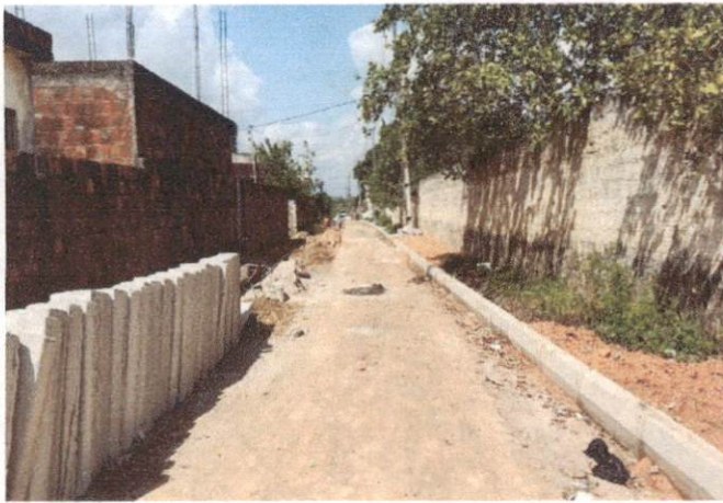
Descrição: RUA ANTÔNIO LOPES (GUADALAJARA): - ITEM 1.4.2 - ASSENTAMENTO DE GUIA (MEIO-FIO)
