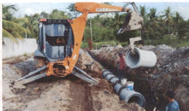
Descrição: AVENIDA DO CANAL ( PRIMAVERA ) – ITEM 1.7.5 - TUBO DE CONCRETO PARA REDES COLETORAS DE ÁGUAS PLUVIAIS, DIÂMETRO DE 600 MM.
