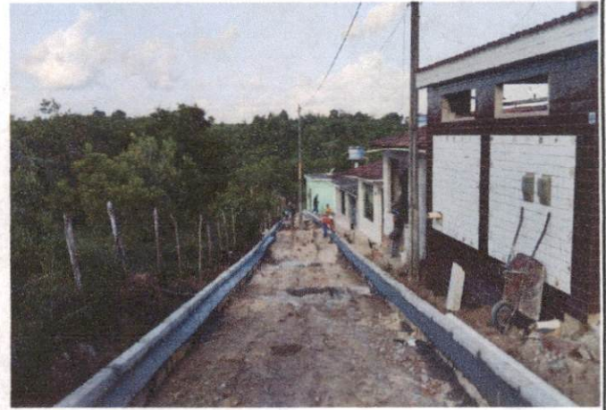
Descrição: RUA ANTÔNIO LOPES (GUADALAJARA): - ITEM 1.4.2 - ASSENTAMENTO DE GUIA (MEIO-FIO) ITEM 1.4.3 - EXECUÇÃO DE SARJETA DE CONCRETO
