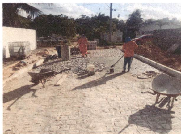
Descrição: AVENIDA DO CANAL ( PRIMAVERA ) – ITEM 1.4.1 - EXECUÇÃO DE PAVIMENTO EM PARALELEPIPEDOS.
