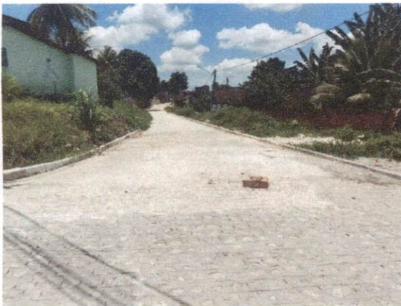
Descrição: RUA AMÉLIA FERREIRA CAVALCANTE (PRIMAVERA) ITEM 1.4.1 - EXECUÇÃO DE PAVIMENTO EM PARALELEPIPEDOS.
