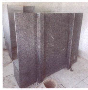
19.1.2 Banco em granito cinza andorinha, espessura 2cm
