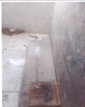
19.1.2 Banco em granito cinza andorinha, espessura 2cm
