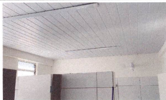
17.4.6 Luminárias 2x40W de sobrepor completa
