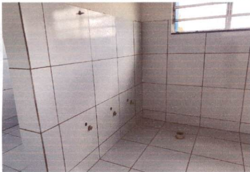
9.1.4 Revestimento cerâmico com placas de dimensões 30x40cm aplicadas à altura inteira das paredes
