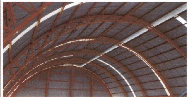
11.3 Pintura esmalte para estrutura metálica, 2 demãos
