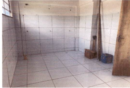
9.1.4 Revestimento cerâmico com placas de dimensões 30x40cm aplicadas à altura inteira das paredes
