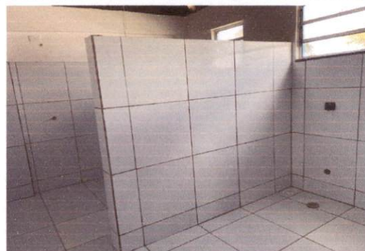
9.1.4 Revestimento cerâmico com placas de dimensões 30x40cm aplicadas à altura inteira das paredes
