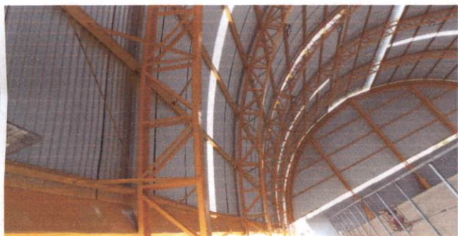
11.2 Pintura prime epóxi para estrutura metálica, 2 demãos
