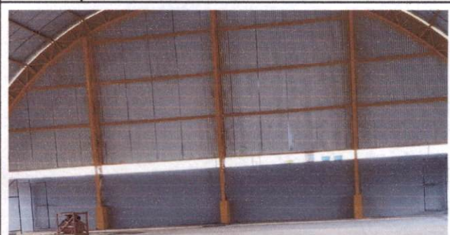
11.3 Pintura esmalte para estrutura metálica, 2 demãos
