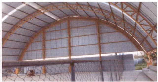
11.2 Pintura prime epóxi para estrutura metálica, 2 demãos
