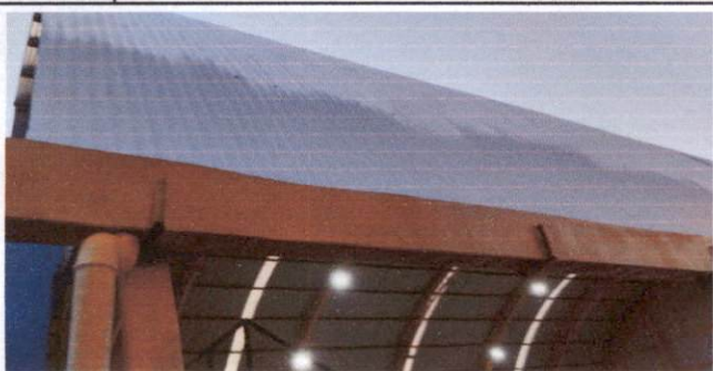
11.3 Pintura esmalte para estrutura metálica, 2 demãos
