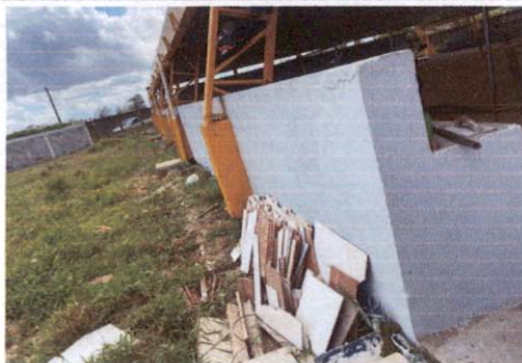
11.1 Pintura prime epóxi para estrutura de concreto, 2 demãos
