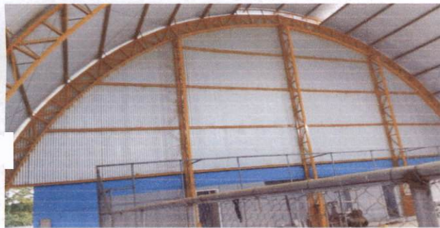
11.2 Pintura prime epóxi para estrutura metálica, 2 demãos
