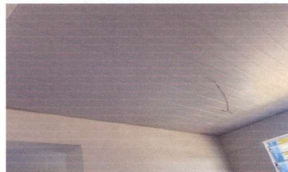
9.3.1 Forro de PVC, inclusive estrutura de fixação
