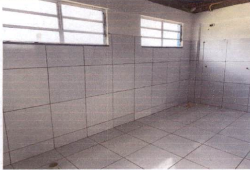
9.1.4 Revestimento cerâmico com placas de dimensões 30x40cm aplicadas à altura inteira das paredes
