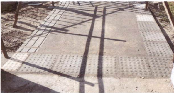
10.5 Piso tátil de alerta em placas pré-moldadas
