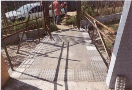
10.4 Rampa de acesso ao pátio coberto em concreto não-estrutural
