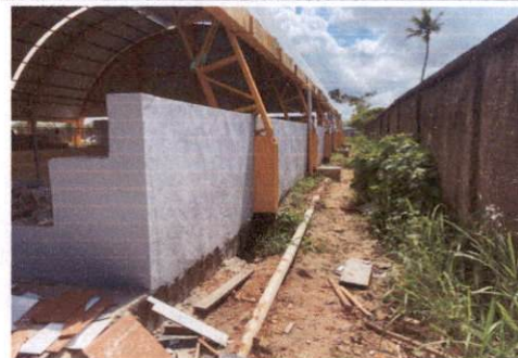
11.1 Pintura prime epóxi para estrutura de concreto, 2 demãos
