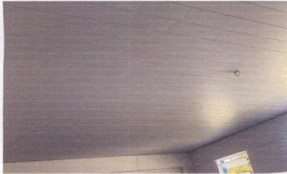
9.3.1 Forro de PVC, inclusive estrutura de fixação
