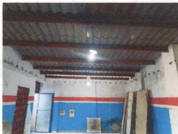
Foto 6: Sala multi uso depois da demolição do forro. Comprova o item 1.3.
