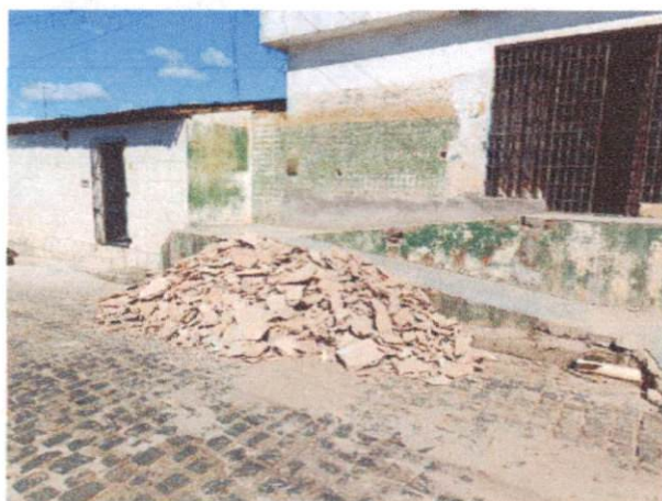
Foto 7: Remoção de guarda-corpo e corrimão. Comprova o item 1.6.
