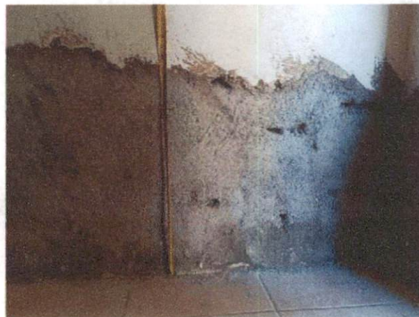
Foto 14: Demolição de argamassa nas paredes. Comprova item 1.9.
