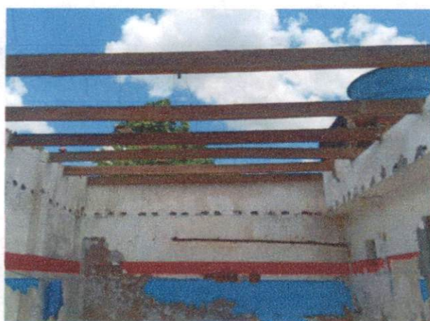
Foto 7: Sala multi uso. Remoção de cobertura de fibrocimento. Comprova o item 1.4.
