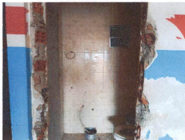
Foto 2: Alvenaria do antigo banheiro depois da demolição. Comprova o item 1.1.
