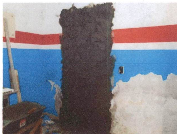
Foto 20: Porta entre a sala multiuso e a copa. Chapisco, emboço. Comprova os itens 2.2 e 2.3.
