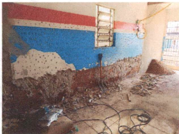
Foto 13: Demolição de argamassa nas paredes. Comprova item 1.9.
