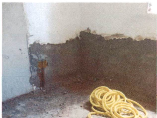
Foto 15: Demolição de argamassa nas paredes. Comprova item 1.9.
