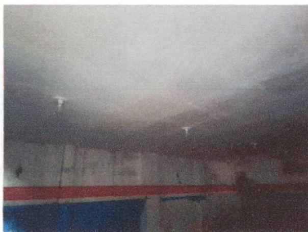
Foto 5: Sala multi uso antes da demolição do forro. Comprova o item 1.3.
