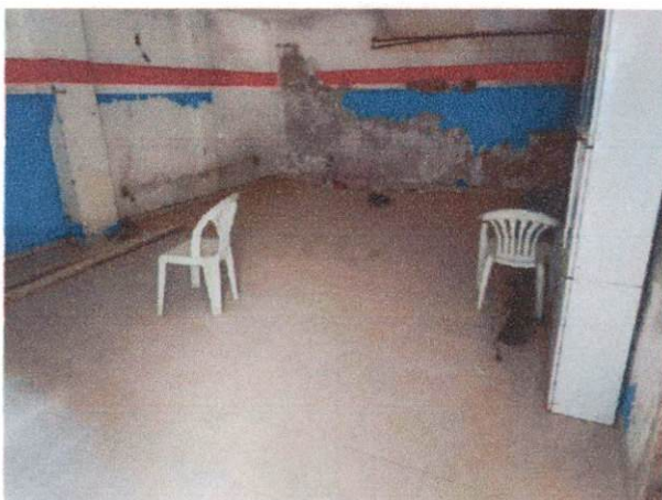
Foto 3: Sala multi uso antes da demolição do piso. Comprova o item 1.2.
