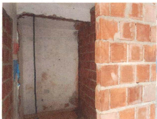
Foto 8: Remoção das bacias e lavatório dos banheiros. Comprova o item 1.7.
