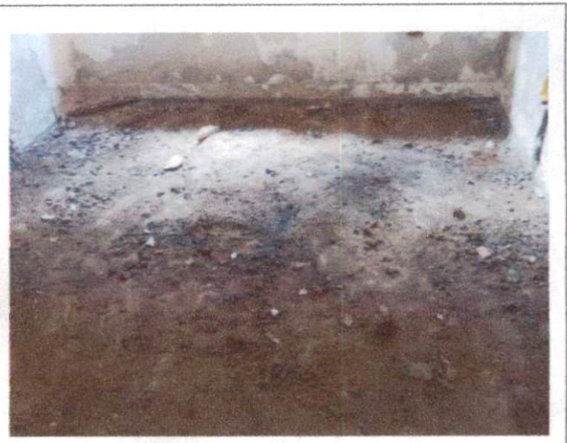
Foto 10: Demolição de pisos. Comprova o item 1.8.
