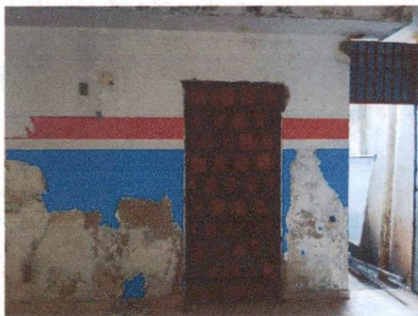
Foto 17: Alvenaria, fechamento da porta entre a sala multiuso e a copa. Comprova o item 2.1.
