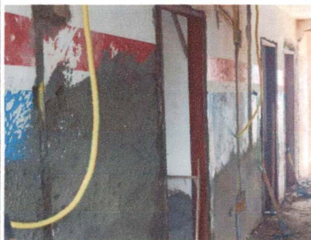
Foto 9: Remoção e de portas e grades e instalação de novas molduras das portas. Comprova o item 1.5.
