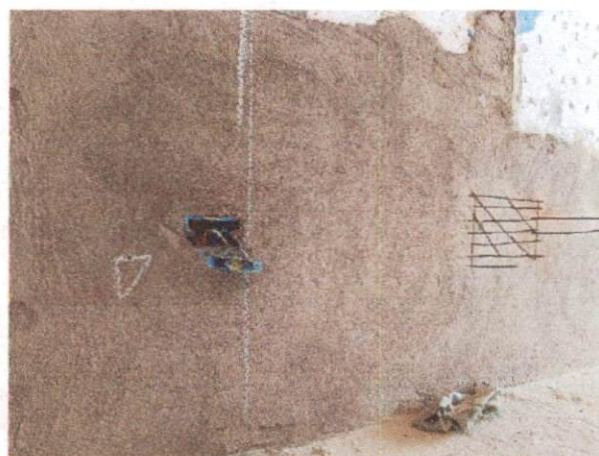
Foto 16: Demolição de argamassa nas paredes. Comprova item 1.9.
