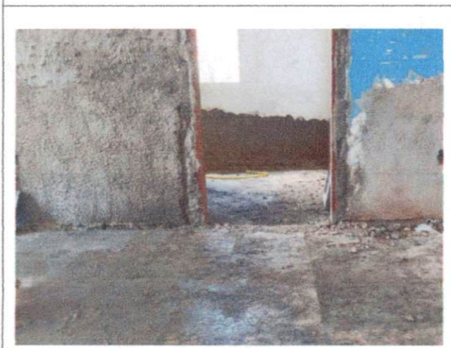
Foto 11: Demolição de pisos. Comprova o item 1.8.
