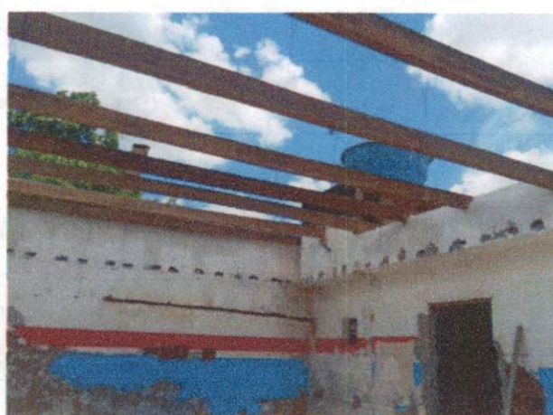
Foto 8: Sala multi uso. Remoção de cobertura de fibrocimento. Comprova o item 1.4.
