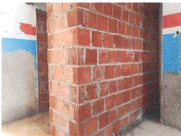
Foto 19: Banheiros PCD, Alvenaria. Comprova o item 2.1.
