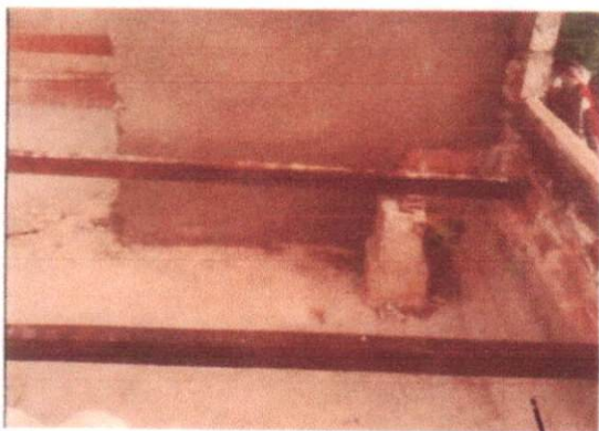
ITEM: 5.3 INSTALAÇÃO DE TRAMA DE MADEIRA ITEM: 5.4 VIGA MADEIRA DE LEI 6 X 12CM ITEM: 7.1 PINTURA IMUNIZANTE PARA MADEIRA, 1 DEMÃO AF_01/2021 CRAS PRIMAVERA
