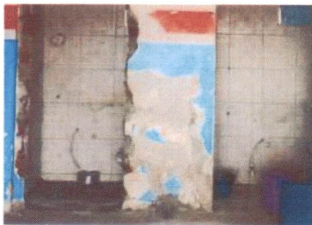
ITEM: 2.6 REMOÇÃO DE LOUÇAS, DE FORMA MANUAL, SEM REAPROVEITAMENTO. AF_12/2017 CRAS PRIMAVERA
