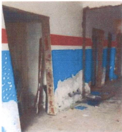
ITEM: 2.4 REMOÇÃO DE PORTAS, DE FORMA MANUAL, SEM REAPROVEITAMENTO. AF_12/2017 CRAS PRIMAVERA
