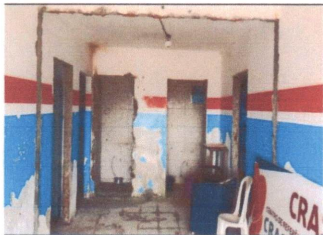
ITEM: 2.3 DEMOLIÇÃO DE ALVENARIA DE BLOCO FURADO, DE FORMA MANUAL, SEM REAPROVEITAMENTO. AF_12/2017 CRAS PRIMAVERA
