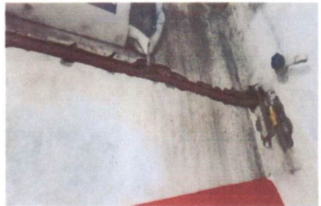
ITEM: 2.8 RASGO EM ALVENARIA PARA RAMAIS/DISTRIBUIÇÃO COM DIAMETROS MENORES OU IGUAIS A 40 MM. AF_05/2015 CRAS PRIMAVERA
