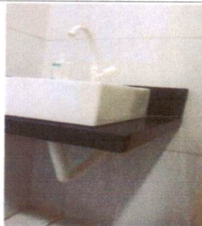
ITEM: 6.1 SIFÃO DO TIPO FLEXÍVEL EM PVC 1 X 1.1/2 - FORNECIMENTO E INSTALAÇÃO. AF_01/2020 CRAS PRIMAVERA
