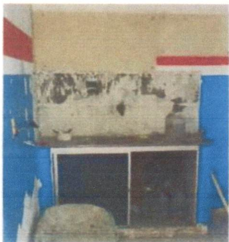
ITEM: 2.5 DEMOLIÇÃO DE REVESTIMENTO CERÂMICO, DE FORMA MANUAL, SEM REAPROVEITAMENTO. AF_12/2017 CRAS PRIMAVERA
