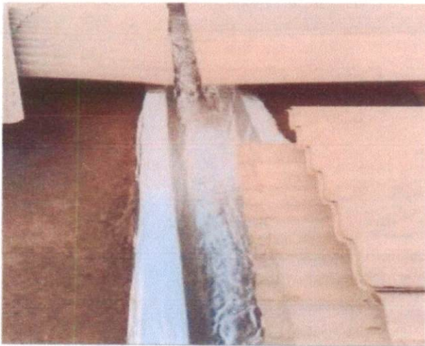
ITEM: 5.2 IMPERMEABILIZAÇÃO DE CALHA, VIGA-CALHA, JARDINEIRA C/MANTA ASFÁLTICA .AUTO-ADESIVA CRAS PRIMAVERA
