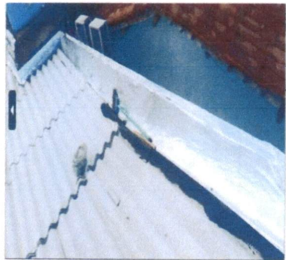
ITEM: 5.2 IMPERMEABILIZAÇÃO DE CALHA, VIGA-CALHA, JARDINEIRA C/MANTA ASFÁLTICA .AUTO-ADESIVA CRAS PRIMAVERA
