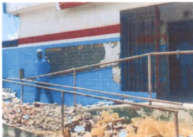
ITEM: 2.5 DEMOLIÇÃO DE REVESTIMENTO CERÂMICO, DE FORMA MANUAL, SEM REAPROVEITAMENTO. AF_12/2017 CRAS PRIMAVERA
