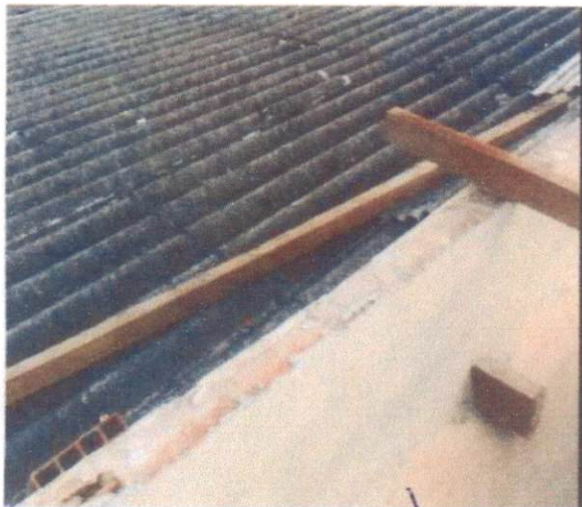
ITEM : 2.9 REMOÇÃO DE TRAMA DE MADEIRA PARA COBERTURA, DE FORMA MANUAL, SEM REAPROVEITAMENTO. AF_12/2017 CRAS PRIMAVERA
