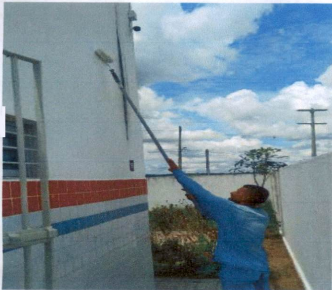
Item: 8.11 APLICAÇÃO MANUAL DE TINTA LÁTEX ACRÍLICA EM PAREDE EXTERNAS DE CASAS, DUAS DEMÃOS. AF 11/2016 UBS ASA BRANCA
