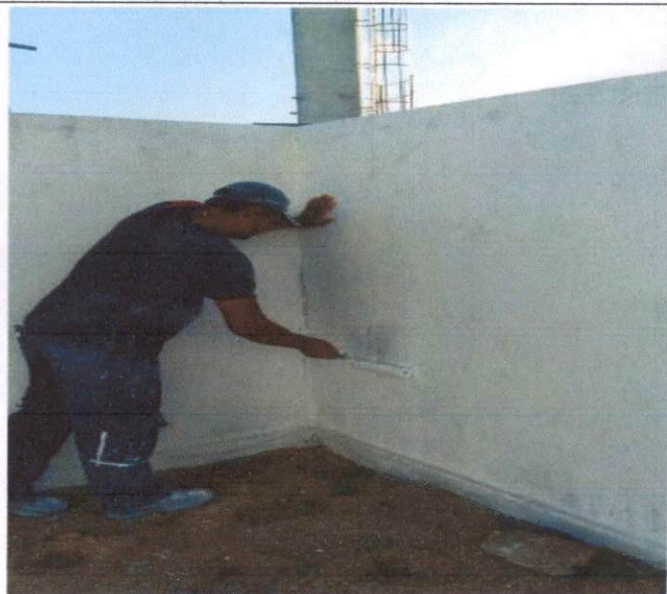
Item: 8.11 APLICAÇÃO MANUAL DE TINTA LÁTEX ACRÍLICA EM PAREDE EXTERNAS DE CASAS, DUAS DEMÃOS. AF 11/2016
