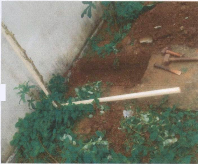
Item: 1.11 ESCAVAÇÃO MANUAL DE VALA COM PROFUNDIDADE MENOR OU IGUAL A 1,30 M.02/2021 UBS ASA BRANCA
