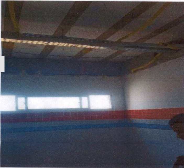
Item: 1.6 REMOÇÃO DE FORRO DE GESSO, DE FORMA MANUAL, SEM REAPROVEITAMENTO. AF_12/2017 UBS ASA BRANCA
