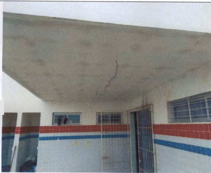
Item: 3.1 FORRO EM PLACAS DE GESSO, PARA AMBIENTES RESIDENCIAIS. AF_05/2017_P UBS ASA BRANCA
