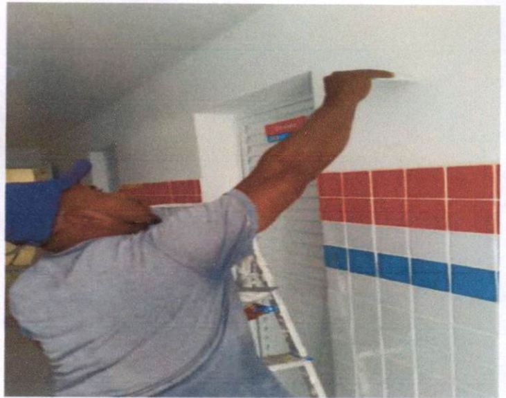
Item : 8.9 APLICAÇÃO E LIXAMENTO DE MASSA LÁTEX EM PAREDES, DUAS DEMÃOS. AF_06/2014 UBS ASA BRANCA
