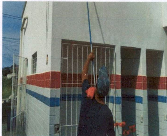
Item: 8.12 PINTURA COM TINTA ALQUÍDICA DE ACABAMENTO (ESMALTE SINTÉTICO ACETINADO) APLICADA A ROLO OU PINCEL SOBRE SUPERFÍCIES METÁLICAS (EXCETO PERFIL) EXECUTADO EM OBRA (02 DEMÃOS). AF 01/2020 UBS ASA BRANCA
