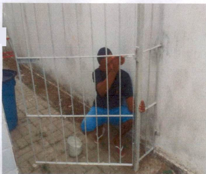
Item: 8.12 PINTURA COM TINTA ALQUÍDICA DE ACABAMENTO (ESMALTE SINTÉTICO ACETINADO) APLICADA A ROLO OU PINCEL SOBRE SUPERFÍCIES METÁLICAS (EXCETO PERFIL) EXECUTADO EM OBRA (02 DEMÃOS). AF 01/2020 UBS ASA BRANCA
