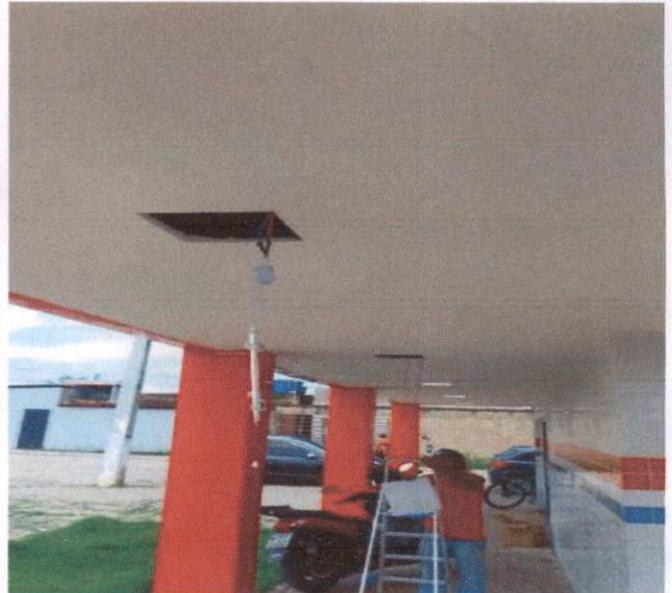
Item: 8.4 APLICAÇÃO MANUAL DE PINTURA COM TINTA LÁTEX ACRÍLICA EM TETO, DUAS DEMÃOS. AF_06/2014 UBS ASA BRANCA
