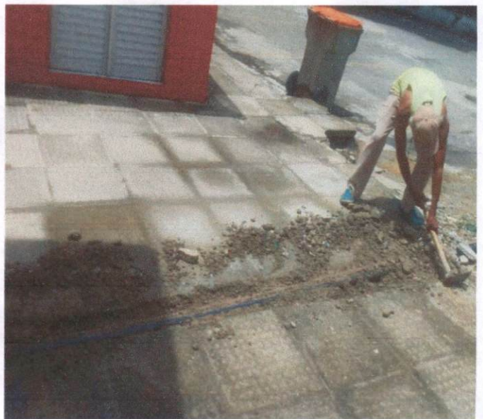
Item: 1.13 DEMOLICAO DE CONCRETO SIMPLES UPA
