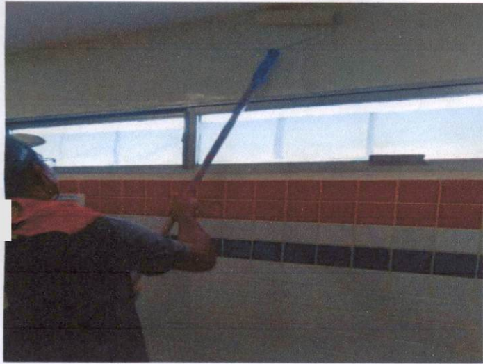
Item: 8.1 APLICAÇÃO MANUAL DE PINTURA COM TINTA LÁTEX ACRÍLICA EM PAREDES, DUAS DEMÃOS. AF 06/2014 UBS ASA BRANCA
