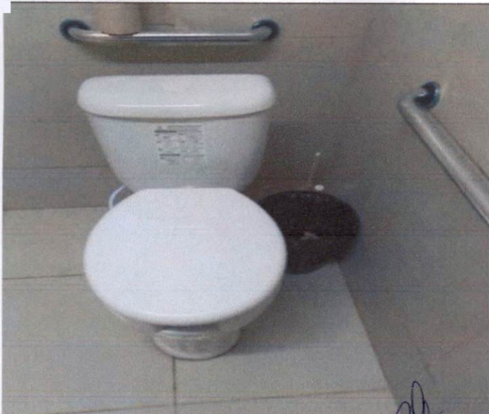
Item: 6.30 BARRA DE APOIO RETA, EM ALUMÍNIO, COMPRIMENTO 90 CM, FIXADA NA PAREDE, FORNECIMENTO E INSTALAÇÃO. AF 01/2020 UBS PRIMA VERA II
