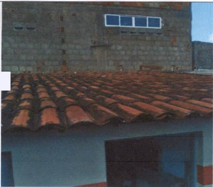
Item: 1.12 RETIRADA E RECOLOCAÇÃO DE TELHA CERÂMICA CAPA-CANAL, COM ATÉ DUAS ÁGUAS, INCLUSO IÇAMENTO. AF 07/2019 UNIDADE CASTRA CANIL
