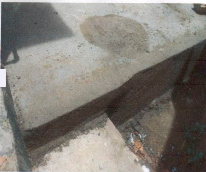
Item: 3.2 EMBOÇO OU MASSA ÚNICA EM ARGAMASSA TRAÇO 1:2:8, PREPARO MANUAL, APLICADA MANUALMENTE EM PANOS CEGOS DE FACHADA (SEM PRESENÇA DE VÃOS), ESPESSURA DE 25 MM. UPA
