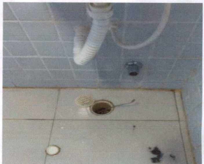
Item: 6.18 SIFÃO DO TIPO FLEXÍVEL EM PVC 1 X 1.1/2 - FORNECIMENTO E INSTALAÇÃO. AF_01/2020 UBS ASA BRANCA
