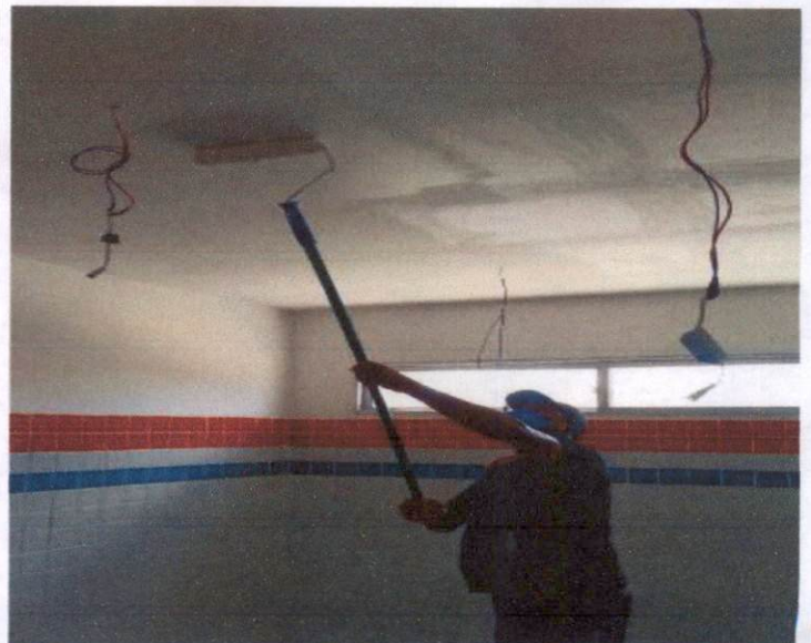
Item: 8.10 APLICAÇÃO DE FUNDO SELADOR ACRÍLICO EM TETO, UMA DEMÃO. AF_06/2014 UBS ASA BRANCA
