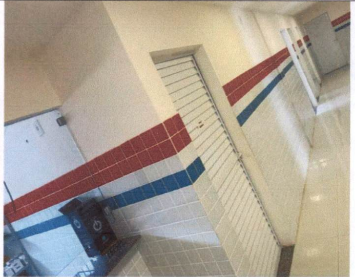
Item: 8.1 APLICAÇÃO MANUAL DE PINTURA COM TINTA LÁTEX ACRÍLICA EM PAREDES, DUAS DEMÃOS. AF 06/2014 UBS ASA BRANCA
