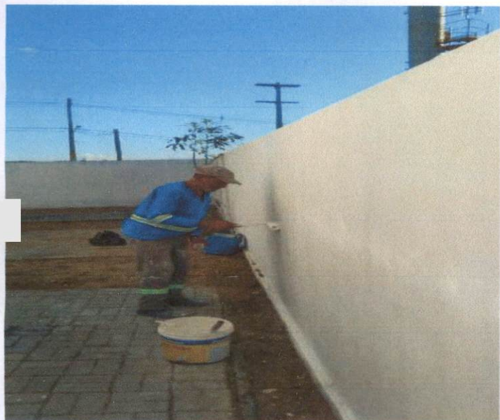
Item: 8.11 APLICAÇÃO MANUAL DE TINTA LÁTEX ACRÍLICA EM PAREDE EXTERNAS DE CASAS, DUAS DEMÃOS. AF 11/2016
