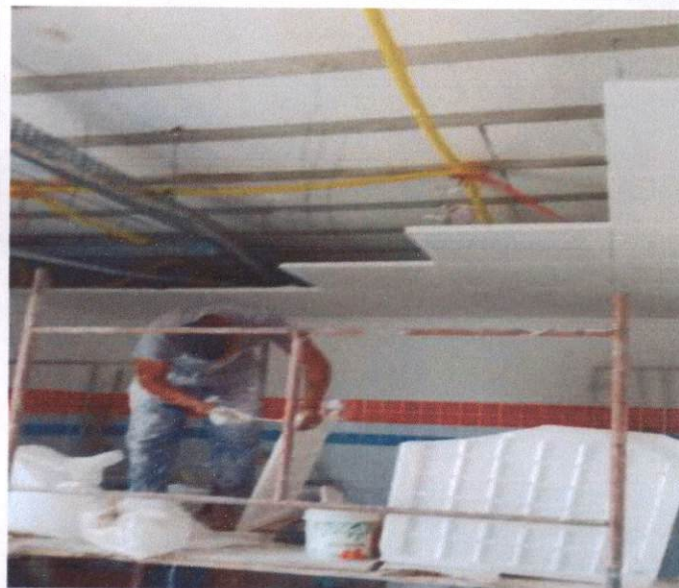
Item: 3.1 FORRO EM PLACAS DE GESSO, PARA AMBIENTES RESIDENCIAIS. AF_05/2017_P UBS ASA BRANCA
