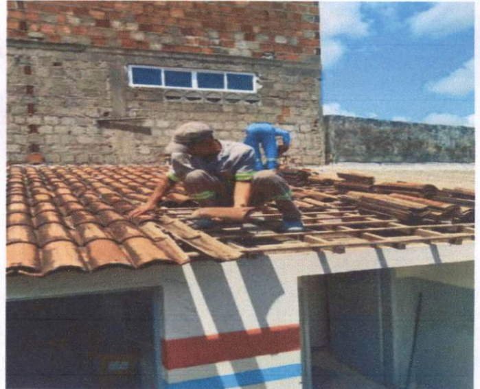
Item: 1.12 RETIRADA E RECOLOCAÇÃO DE TELHA CERÂMICA CAPA-CANAL, COM ATÉ DUAS ÁGUAS, INCLUSO IÇAMENTO. AF 07/2019 UNIDADE CASTRA CANIL
