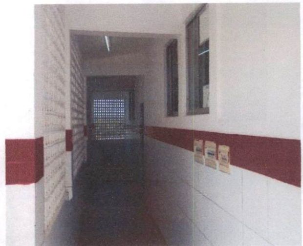
Foto 20: Pintura látex em paredes internas (item 1.1) e pintura a óleo (item 1.2) na Escola Municipal Tancredo Neves
