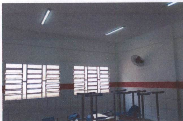
Foto 36: Pintura látex em paredes internas (item 1.1) e pintura a óleo (item 1.2) na Escola Municipal Manoel da Rosa
