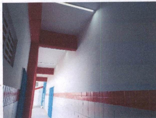
Foto 38: Pintura látex em paredes internas (item 1.1) e pintura a óleo (item 1.2) na Escola Municipal Manoel da Rosa
