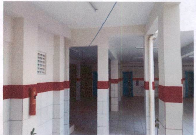
Foto 6: Pintura a óleo (item 1.2) e pintura látex em paredes externas (Item 1.3) na Escola Municipal de Paudalho (CMP)
