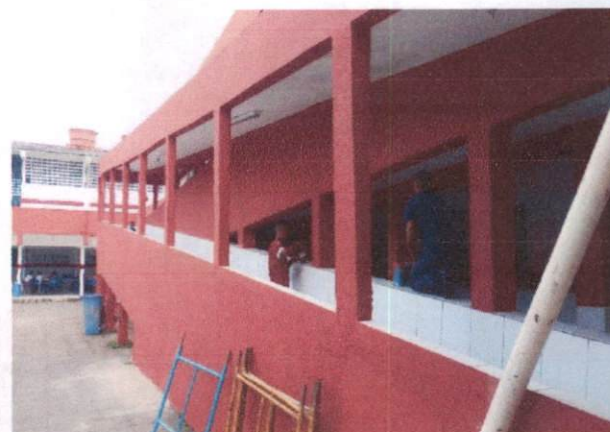
Foto 28: Pintura látex em paredes externas (item 1.3) na Escola Municipal Tancredo Neves
