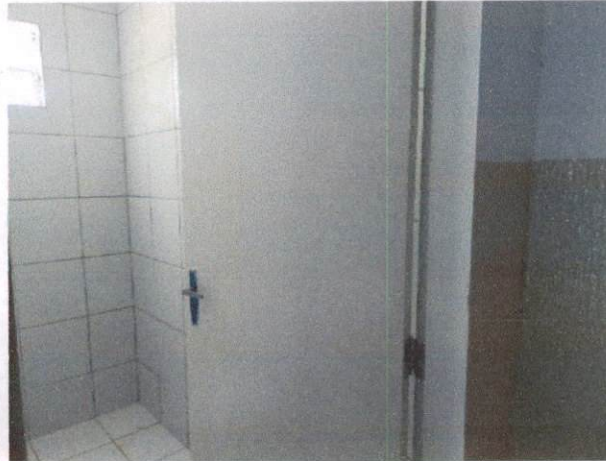
Foto 56: Pintura látex em paredes internas (item 1.1) e pintura a óleo (item 1.2) no CEDECOP
