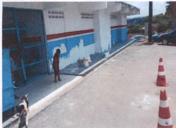
Foto 31: Aplicação e lixamento de Massa. (Item 1.4) na Escola Municipal Tancredo Neves.
