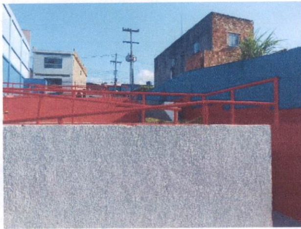
Foto 41: Pintura a óleo (item 1.2) e Pintura látex em paredes externas (item 1.3) na Escola Municipal Manoel da Rosa
