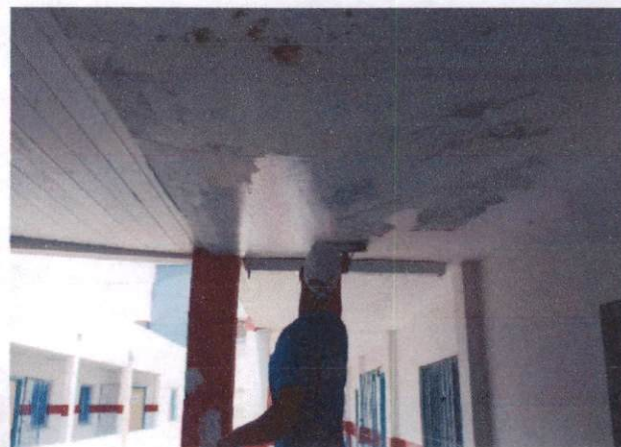
Foto 10: Aplicação e lixamento de Massa. (Item 1.4) na Escola Municipal de Paudalho (CMP).
