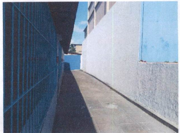
Foto 50: Aplicação de tinta texturizada (Item 1.5) na Escola Municipal Manoel da Rosa
