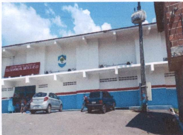
Foto 23: Pintura a óleo (item 1.2) e Pintura látex em paredes externas (item 1.3) na Escola Municipal Tancredo Neves
