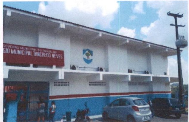
Foto 22: Pintura a óleo (item 1.2) e Pintura látex em paredes externas (item 1.3) na Escola Municipal Tancredo Neves
