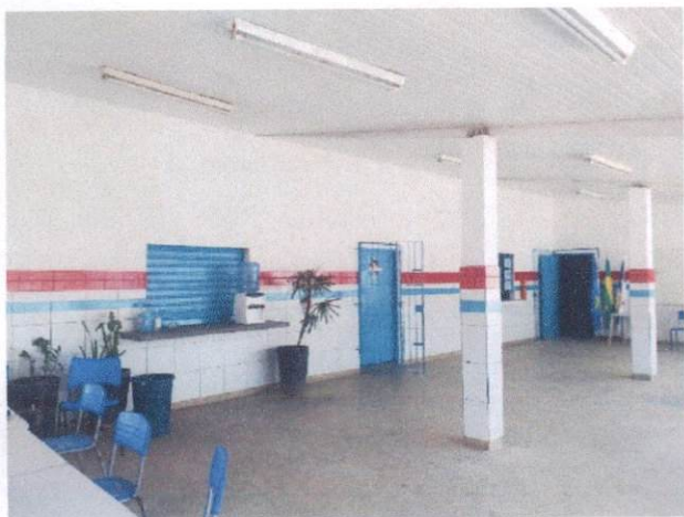
Foto 39: Pintura látex em paredes internas (item 1.1) e pintura a óleo (item 1.2) na Escola Municipal Manoel da Rosa
