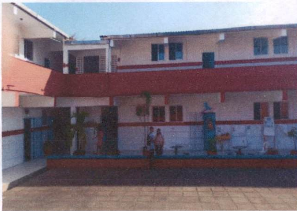
Foto 29: Pintura látex em paredes externas (item 1.3) na Escola Municipal Tancredo Neves.
