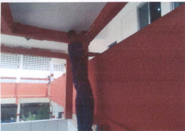
Foto 27: Pintura látex em paredes externas (item 1.3) na Escola Municipal Tancredo Neves
