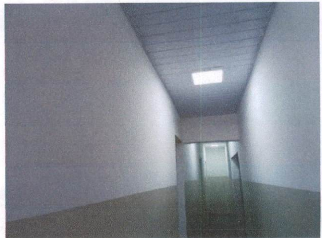
Foto 58: Pintura látex em paredes internas (item 1.1) e pintura a óleo (item 1.2) no CEDECOP
