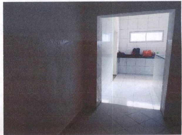
Foto 60: Aplicação de tinta texturizada (Item 1.5) no CEDECOP
