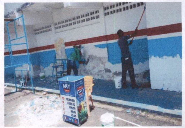
Foto 32: Aplicação e lixamento de Massa. (Item 1.4) na Escola Municipal Tancredo Neves.
