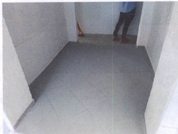
Foto 62: Pintura acrílica em piso (Item 2.4) no CEDECOP
