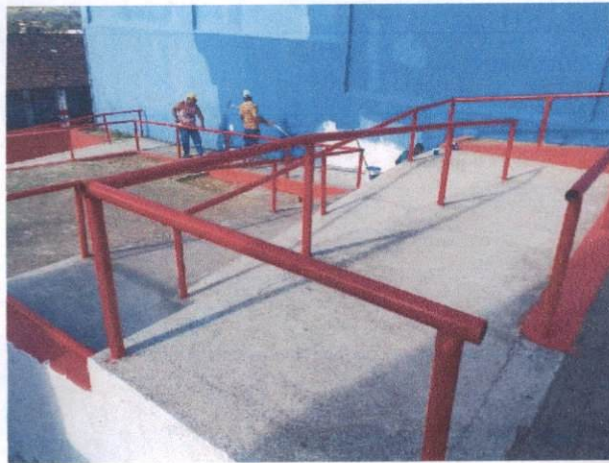
Foto 43: Pintura a óleo (item 1.2) e Pintura látex em paredes externas (item 1.3) na Escola Municipal Manoel da Rosa
