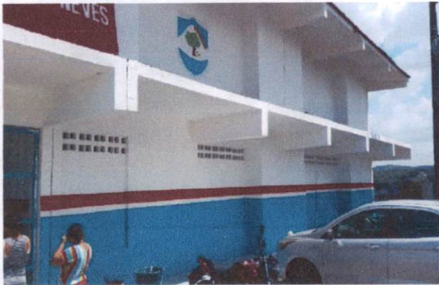
Foto 21: Pintura a óleo (item 1.2) e Pintura látex em paredes externas (item 1.3) na Escola Municipal Tancredo Neves
