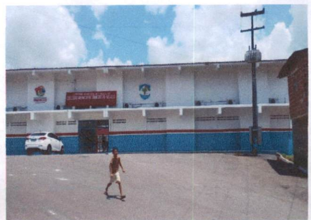
Foto 24: Pintura a óleo (item 1.2) e Pintura látex em paredes externas (item 1.3) na Escola Municipal Tancredo Neves
