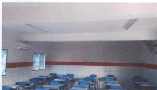
Foto 3: Pintura látex em paredes internas (item 1.1) e pintura a óleo (item 1.2) na Escola Municipal de Paudalho (CMP).
