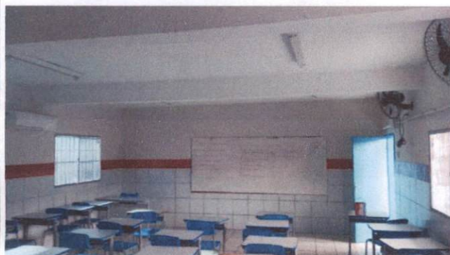
Foto 1: Pintura látex em paredes internas (item 1.1) e pintura a óleo (item 1.2) na Escola Municipal de Paudalho (CMP).
