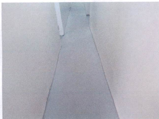
Foto 63: Pintura acrílica em piso (Item 2.4) no CEDECOP
