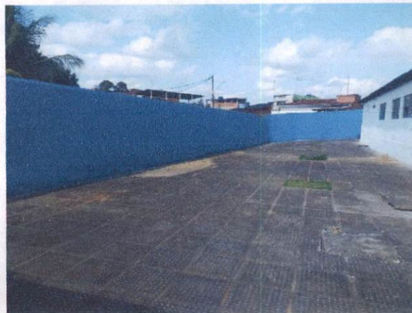
Foto 46: Pintura látex em paredes externas (Item 1.3) na Escola Municipal Manoel da Rosa
