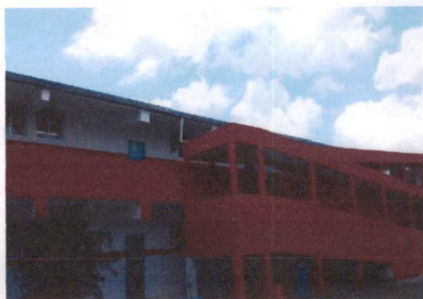
Foto 26: Pintura látex em paredes externas (item 1.3) na Escola Municipal Tancredo Neves
