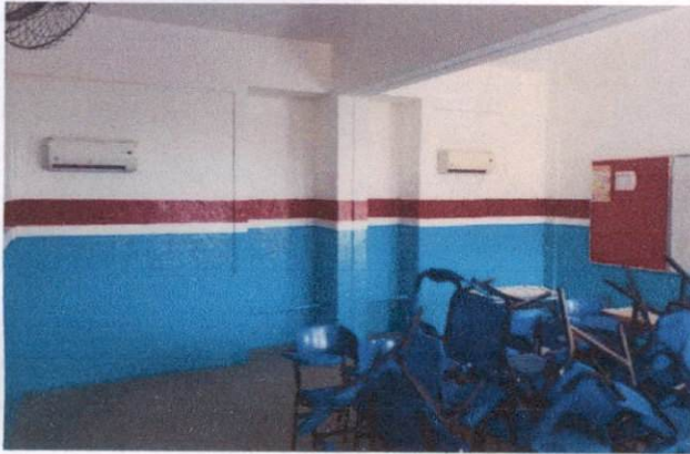
Foto 13: Pintura látex em paredes internas (item 1.1) e pintura a óleo (item 1.2) na Escola Municipal Tancredo Neves.
