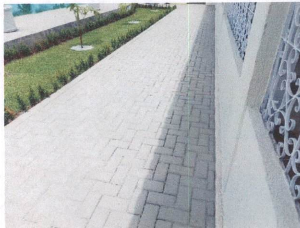
Foto 64: Pintura acrílica em piso (Item 2.4) no CEDECOP
