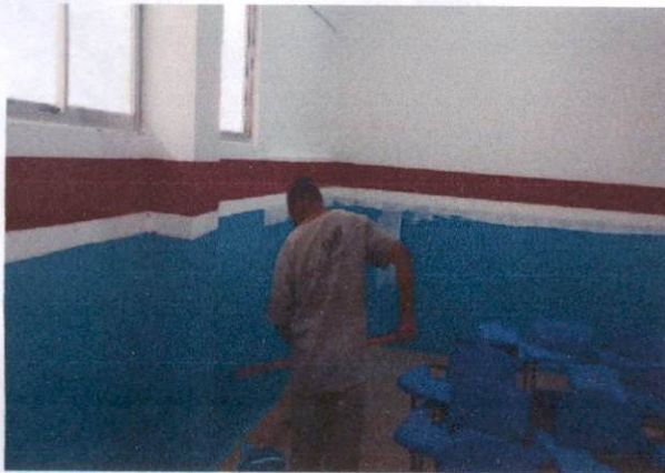
Foto 15: Pintura látex em paredes internas (item 1.1) e pintura a óleo (item 1.2) na Escola Municipal Tancredo Neves
