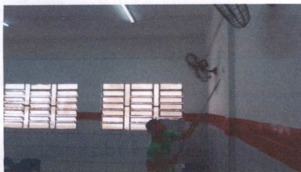
Foto 35: Pintura látex em paredes internas (item 1.1) e pintura a óleo (item 1.2) na Escola Municipal Manoel da Rosa
