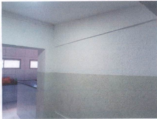
Foto 59: Aplicação de tinta texturizada (Item 1.5) no CEDECOP
