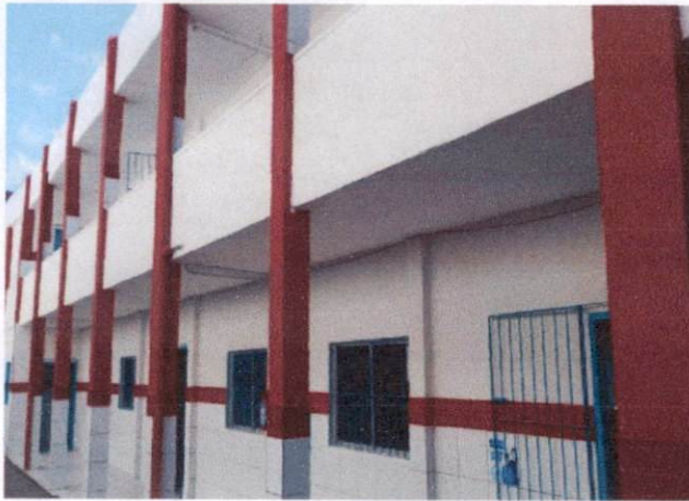
Foto 5: Pintura a óleo (item 1.2) e pintura látex em paredes externas (Item 1.3) na Escola Municipal de Paudalho (CMP).
