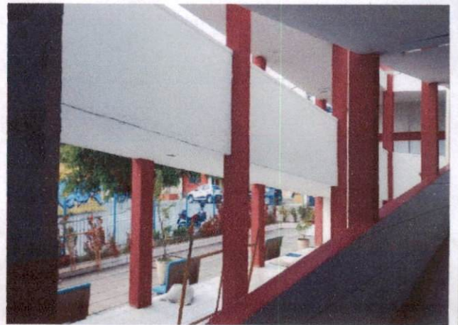
Foto 8: Pintura látex em paredes externas (Item 1.3) na Escola Municipal de Paudalho (CMP)
