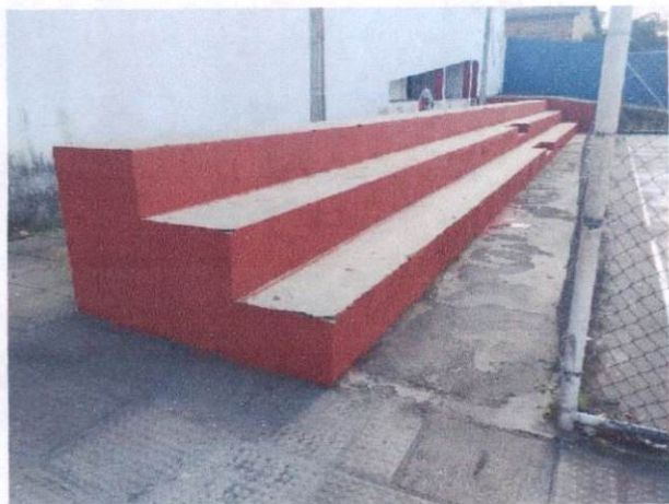
Foto 45: Pintura látex em paredes externas (Item 1.3) na Escola Municipal Manoel da Rosa
