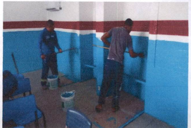
Foto 16: Pintura látex em paredes internas (item 1.1) e pintura a óleo (item 1.2) na Escola Municipal Tancredo Neves
