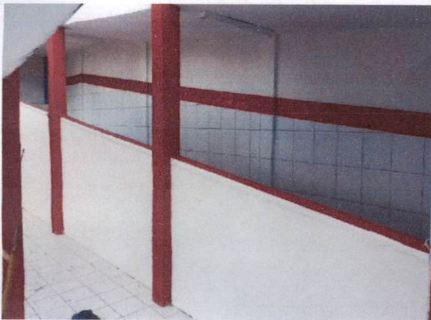
Foto 7: Pintura látex em paredes externas (Item 1.3) na Escola Municipal de Paudalho (CMP)
