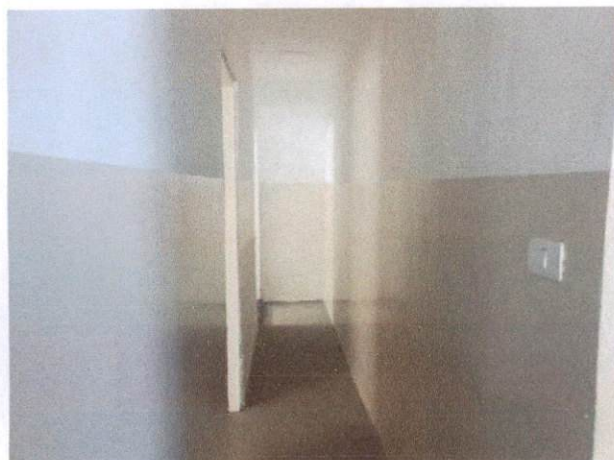
Foto 53: Pintura látex em paredes internas (item 1.1) e pintura a óleo (item 1.2) no CEDECOP
