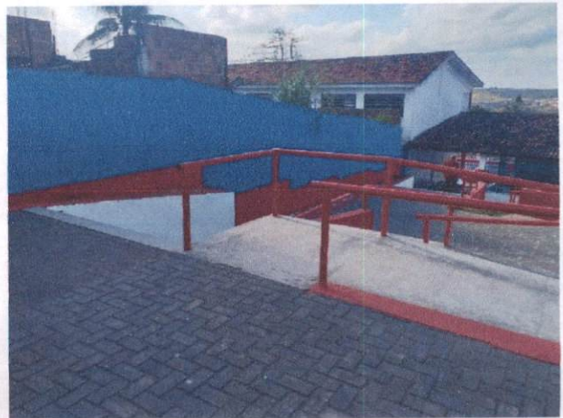
Foto 42: Pintura a óleo (item 1.2) e Pintura látex em paredes externas (item 1.3) na Escola Municipal Manoel da Rosa
