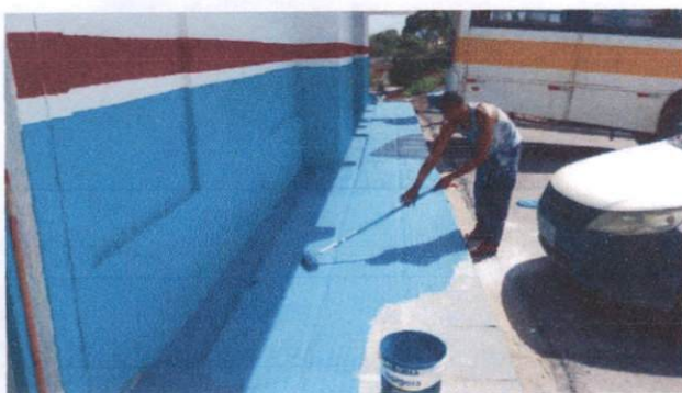
Foto 33: Pintura acrílica em piso (item 2.4) na Escola Municipal Tancredo Neves.
