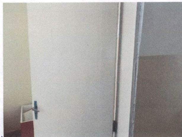
Foto 55: Pintura látex em paredes internas (item 1.1) e pintura a óleo (item 1.2) no CEDECOP
