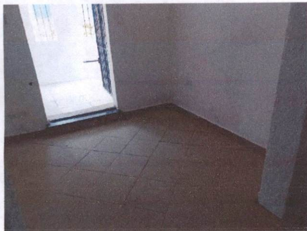
Foto 61: Pintura acrílica em piso (Item 2.4) no CEDECOP
