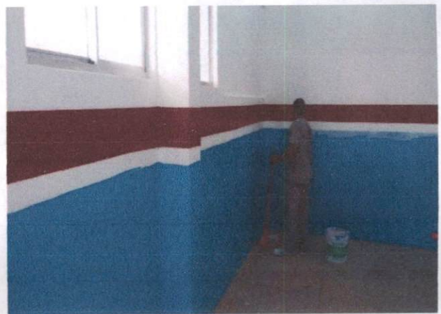
Foto 18: Pintura látex em paredes internas (item 1.1) e pintura a óleo (item 1.2) na Escola Municipal Tancredo Neves
