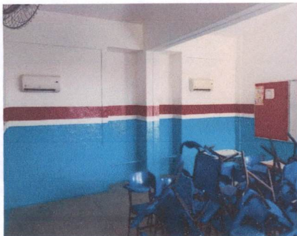
Foto 19: Pintura látex em paredes internas (item 1.1) e pintura a óleo (item 1.2) na Escola Municipal Tancredo Neves
