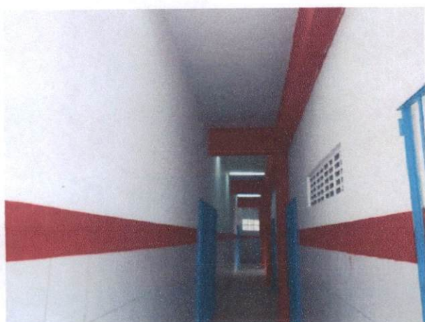
Foto 37: Pintura látex em paredes internas (item 1.1) e pintura a óleo (item 1.2) na Escola Municipal Manoel da Rosa
