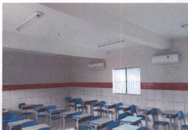
Foto 4: Pintura látex em paredes internas (item 1.1) e pintura a óleo (item 1.2) na Escola Municipal de Paudalho (CMP).
