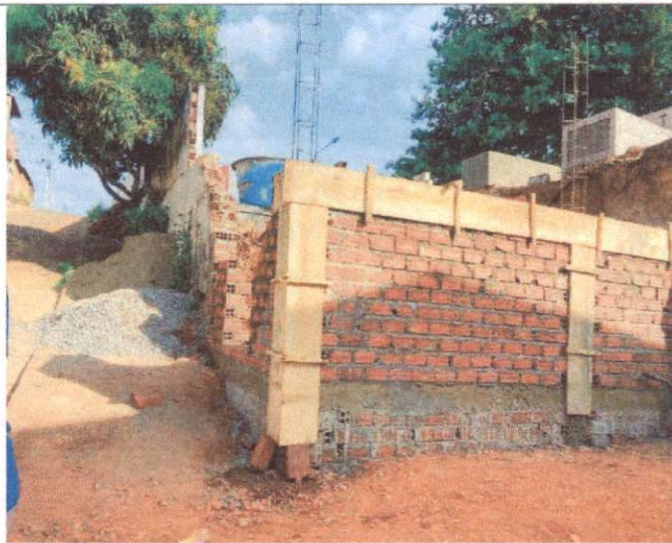
Item: 4.5 (COMPOSIÇÃO REPRESENTATIVA) DO SERVIÇO DE ALVENARIA DE VEDAÇÃO DE BLOCOS VAZADOS DE CERÂMICA DE 9X19X19CM (ESPESSURA 9CM), PARA EDIFICAÇÃO HABITACIONAL MULTIFAMILIAR (PRÉDIO). AF_11/2014
