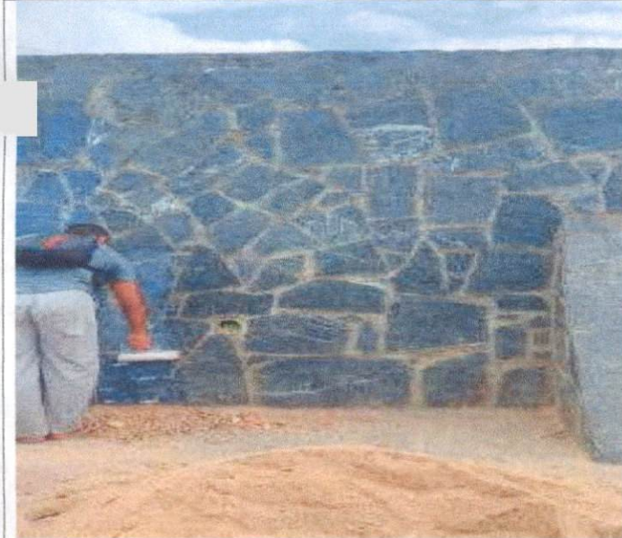
Item: 10.14 PINTURA COM RESINA ACRÍLICA, EM PAREDES.
