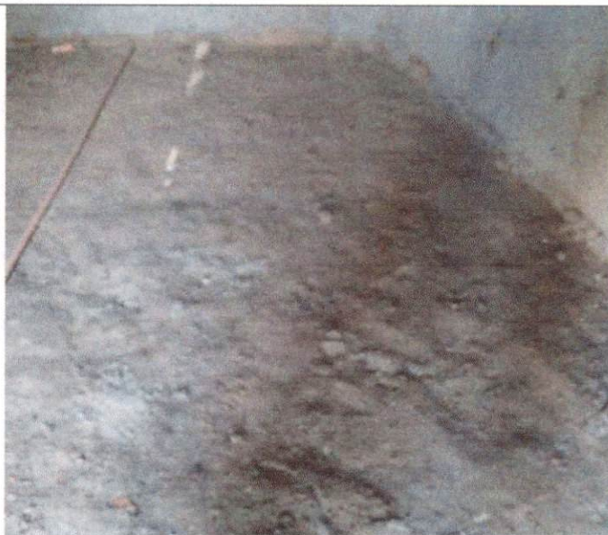
Item: 2.21 ESCAVAÇÃO MANUAL DE VALA COM PROFUNDIDADE MENOR OU IGUAL A 1,30 M. AF_02/2021
