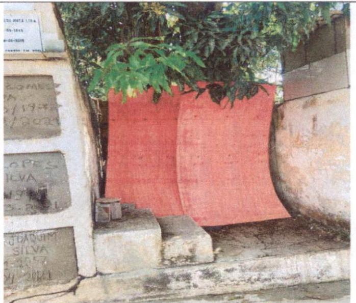
Item: 2.17 TAPUME COM COMPENSADO DE MADEIRA. AF_05/2018
