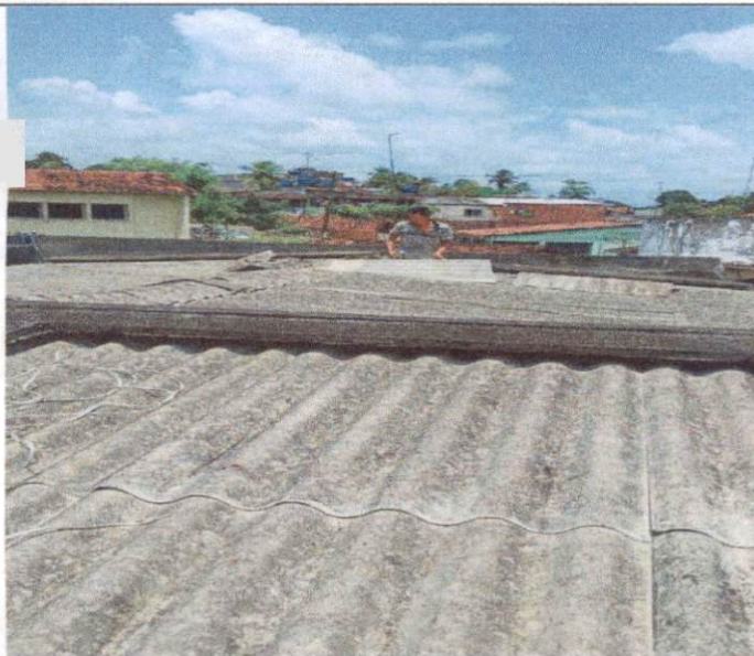
Item: 2.14 RECOLOCAÇÃO DE TELHA DE FIBROCIMENTO
