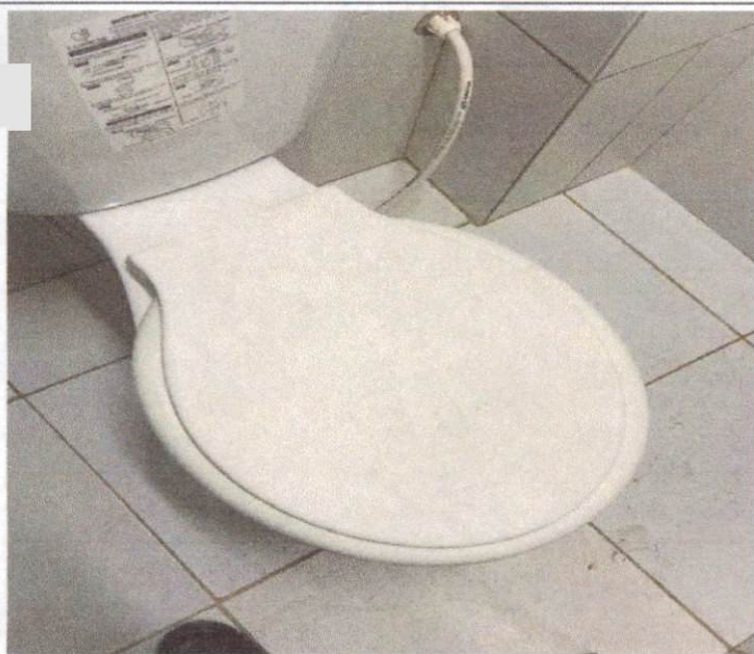
Item 11.9 ASSENTO SANITÁRIO CONVENCIONAL - FORNECIMENTO E INSTALACAO. AF_01/2020
