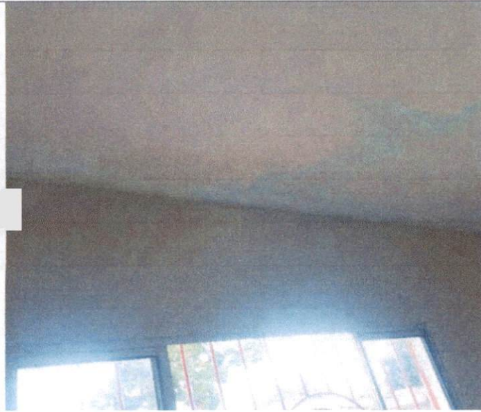
Item: 10.6 APLICAÇÃO E LIXAMENTO DE MASSA LÁTEX EM TETO, DUAS DEMÃOS. AF_06/2014
