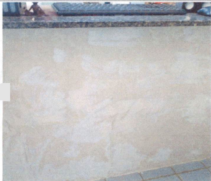
Item: 10.4 APLICAÇÃO E LIXAMENTO DE MASSA LÁTEX EM PAREDES, DUAS DEMÃOS. AF_06/2014
