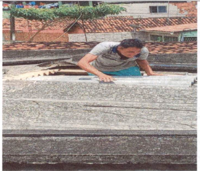
Item: 2.14 RECOLOCAÇÃO DE TELHA DE FIBROCIMENTO
