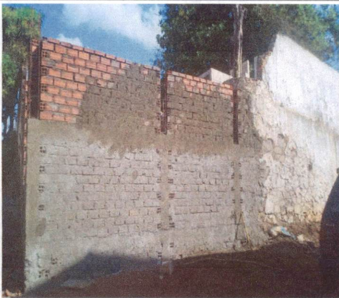
Item: 4.1 CHAPISCO APLICADO EM ALVENARIA E ESTRUTURAS DE CONCRETO INTERNAS, COM COLHER DE PEDREIRO, ARGAMASSA TRAÇO 1:3 COM PREPARO MANUAL
