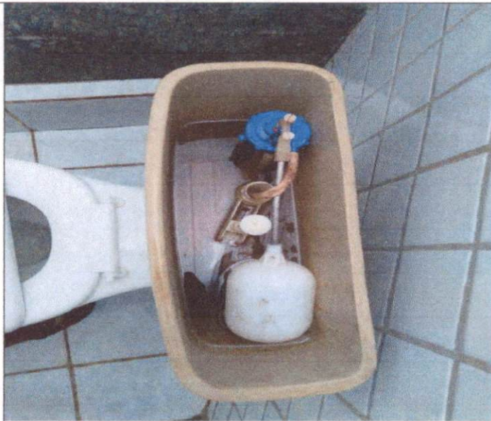
Item: 11.9 REPARO PARA CAIXA DE DESCARGA ACOPLADA
