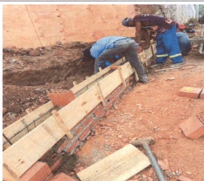
Item: 12.1 MONTAGEM E DESMONTAGEM DE FÔRMA DE PÍLARES RETANGULARES E ESTRUTURAS SIMILARES, PÊ-DIREITO SIMPLES, EM MADEIRA SERRADA, 2 UTILIZAÇÕES. AF_09/2020
