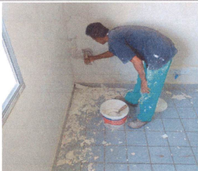
Item: 10.4 APLICAÇÃO E LIXAMENTO DE MASSA LÁTEX EM PAREDES, DUAS DEMÃOS. AF_06/2014
