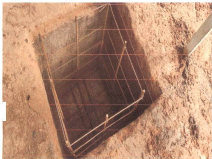
Item: 2.1 ESCAVACAO MANUAL EM TERRA ATE 1,50 M DE PROFUNDIDADE, SEM ESCORAMENTO. SAPATAS PARA PILARES MÓVEIS DA USINA
