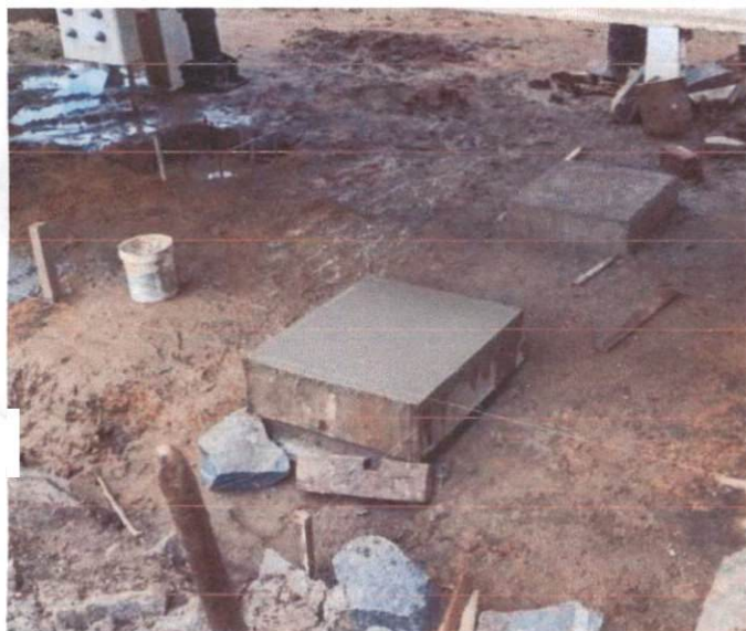
Item 4.1 FABRICAÇÃO, FABRICAÇÃO DE FÔRMA PARA PILARES E ESTRUTURAS SIMILARES, EM MADEIRA SERRADA, E=25 MM. AF_09/2020 PILARES DA USINA
