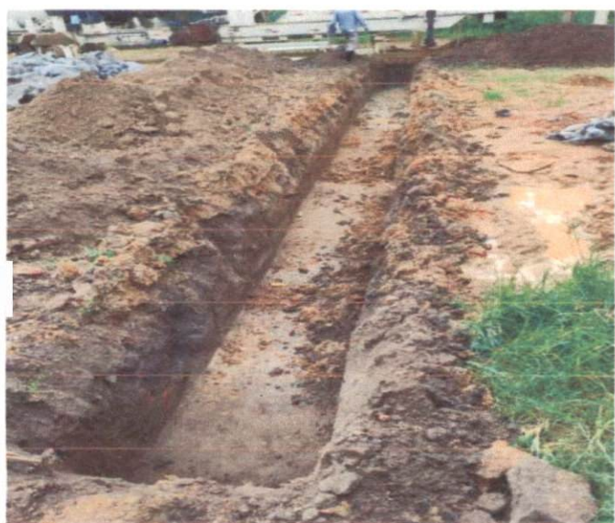
Item: 2.1 ESCAVACAO MANUAL EM TERRA ATE 1,50 M DE PROFUNDIDADE, SEM ESCORAMENTO. SAPATAS PARA PILARES MÓVEIS DA USINA
