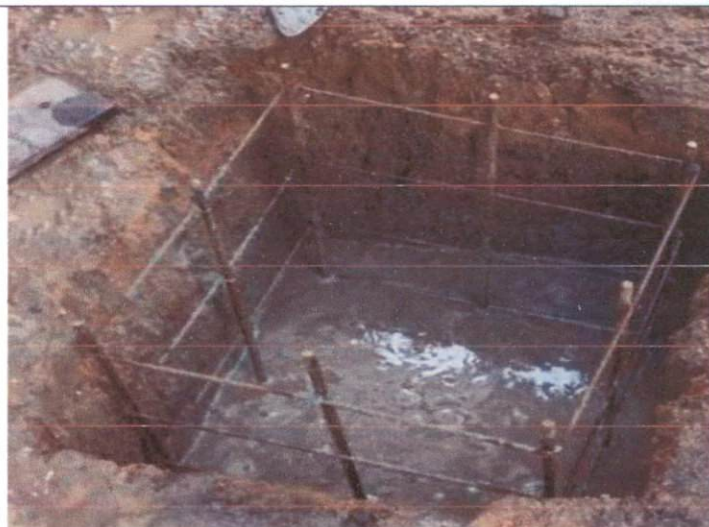
Item: 2.1 ESCAVACAO MANUAL EM TERRA ATE 1,50 M DE PROFUNDIDADE, SEM ESCORAMENTO. SAPATAS PARA PILARES MÓVEIS DA USINA
