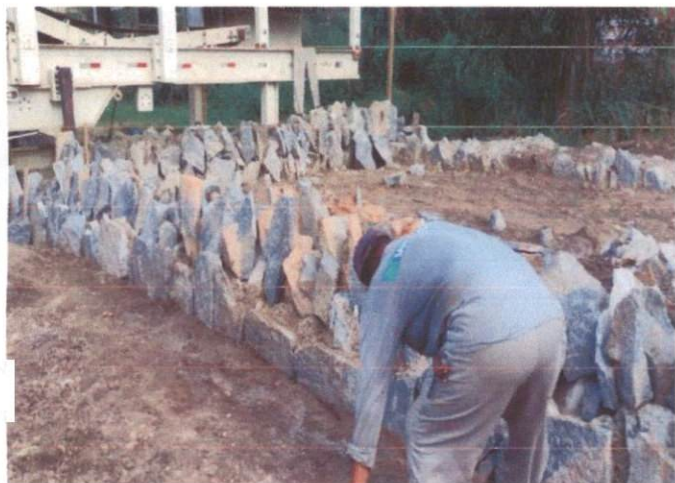
Item: 5.2; ALVENARIA EM PEDRA RACHAO ASSENTADA E REJUNTA DA COM ARGAMASSA DE CIMENTO E AREIA NO TRACO 1:6. BASE DA RAMPA
