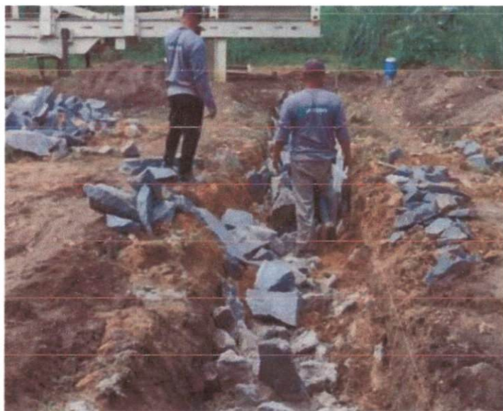
Item: 2.1 ESCAVACAO MANUAL EM TERRA ATE 1,50 M DE PROFUNDIDADE, SEM ESCORAMENTO. SAPATAS PARA PILARES MÓVEIS DA USINA
