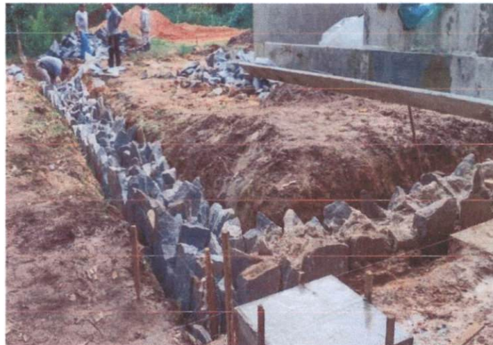
Item: 5.2; ALVENARIA EM PEDRA RACHAO ASSENTADA E REJUNTA DA COM ARGAMASSA DE CIMENTO E AREIA NO TRACO 1:6. BASE DA RAMPA
