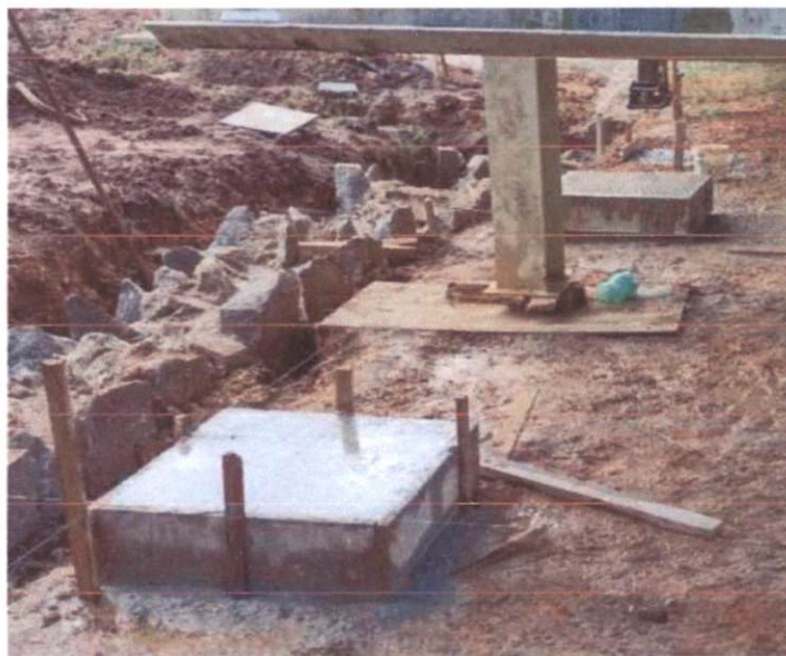
Item 4.1 FABRICAÇÃO, FABRICAÇÃO DE FÔRMA PARA PILARES E ESTRUTURAS SIMILARES, EM MADEIRA SERRADA, E=25 MM. AF_09/2020 PILARES DA USINA
