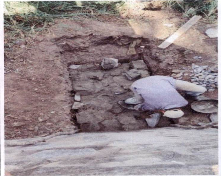
Item: 5.1 " "EXECUÇÃO DE VIA EM PISO INTERTRAVADO, COM BLOCO RETANGULAR COR NATURAL DE 20 X 10 CM, ESPESSURA 8 CM. PAVER CENTRAL
