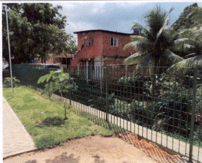
Item: 5.1 "EXECUÇÃO DE VIA EM PISO INTERTRAVADO, COM BLOCO RETANGULAR COR NATURAL DE 20 X 10 CM, ESPESSURA 8 CM. PAVEN CENTRAL
