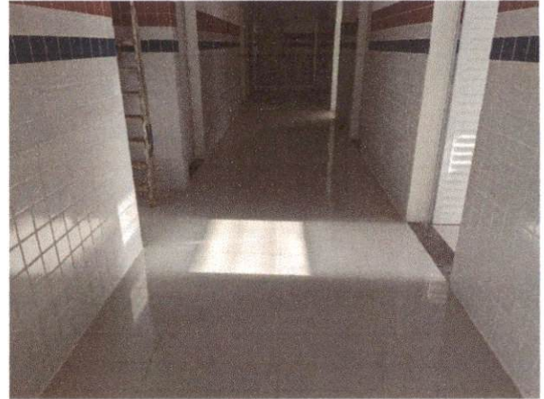
Descrição: LIMPEZA FINAL DA OBRA
