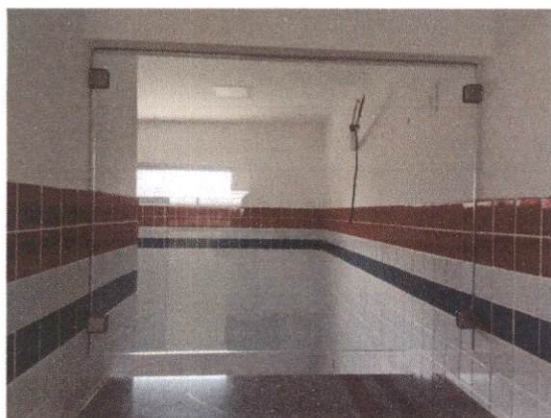
Descrição: FORNECIMENTO E INSTALAÇÃO DE VIDRO TEMPERADO COM ESPESSURA DE 10MM, INCLUSIVE FERRAGENS
