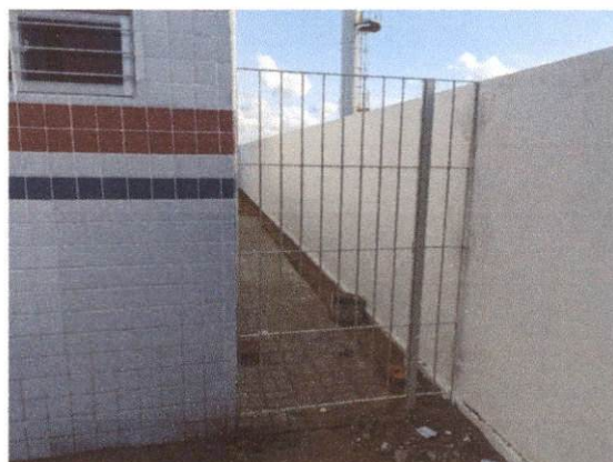
Descrição: PORTA DE FERRO DE ABRIR TIPO BARRA CHATA, COM REQUADRO E GUARNICAO COMPLETA.
