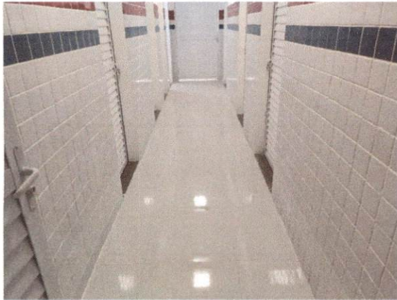
Descrição: LIMPEZA FINAL DA OBRA
