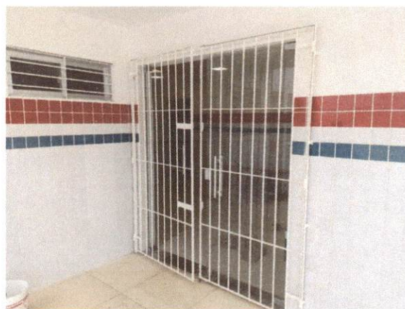
Descrição: PINTURA COM ESMALTE SINTÉTICO EM ESQUADRIA DE FERRO, DUAS DEMÃOS, COM RASPAGEM E APARELHAMENTO COM ZARCÃO.
