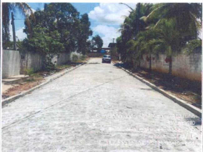
Descrição: RUA JOÃO JOSÉ MONTEIRO (TABARUNA) ITEM 16.2.1 - EXECUÇÃO DE PAVIMENTO EM PARALELEPÍEDOS, REJUNTAMENTO COM ARGAMASSA TRAÇO 1:3 (CIMENTO E AREIA). AF_05/2020 – COORDENADAS – 7.97758, - 35.141514
