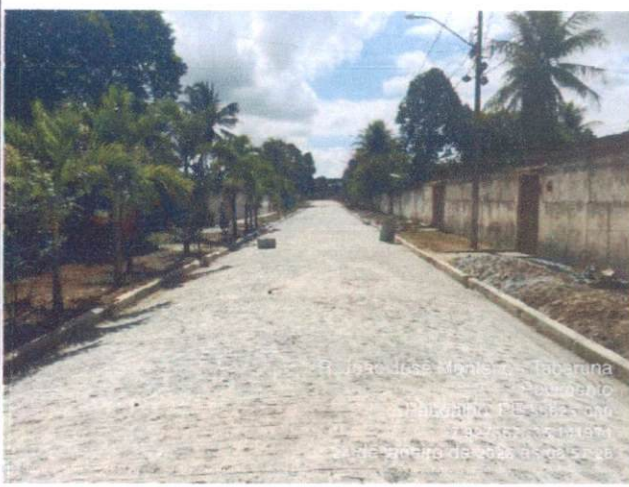
Descrição: RUA JOÃO JOSÉ MONTEIRO (TABARUNA) ITEM 16.2.1 - EXECUÇÃO DE PAVIMENTO EM PARALELEPÍEDOS, REJUNTAMENTO COM ARGAMASSA TRAÇO 1:3 (CIMENTO E AREIA). AF_05/2020 – COORDENADAS – 7.927552, - 35.141971
