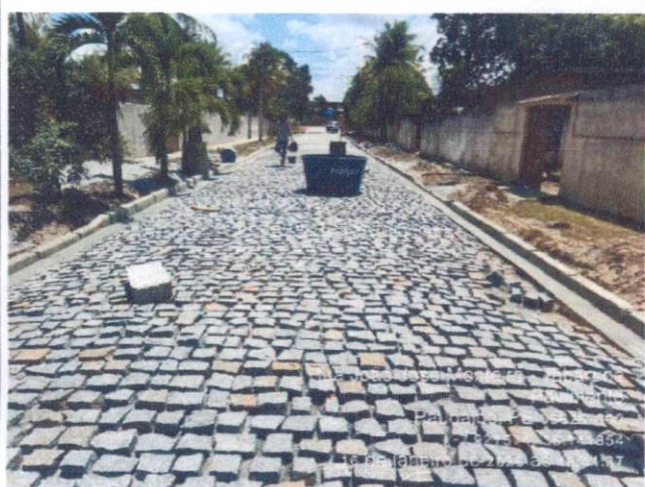
Descrição: RUA JOÃO JOSÉ MONTEIRO (TABARUNA) ITEM 16.2.1 - EXECUÇÃO DE PAVIMENTO EM PARALELEPÍEDOS, REJUNTAMENTO COM ARGAMASSA TRAÇO 1:3 (CIMENTO E AREIA). AF_05/2020 – COORDENADAS – 7.927574, - 35.141854
