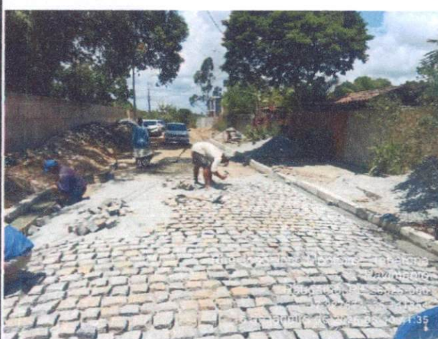
Descrição: RUA JOÃO JOSÉ MONTEIRO (TABARUNA) ITEM 16.2.1 - EXECUÇÃO DE PAVIMENTO EM PARALELEPÍEDOS, REJUNTAMENTO COM ARGAMASSA TRAÇO 1:3 (CIMENTO E AREIA). AF_05/2020 – COORDENADAS – 7.927574, - 35.141854
