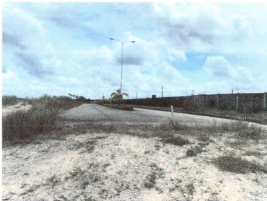
1- Via em que está localizado o terreno
